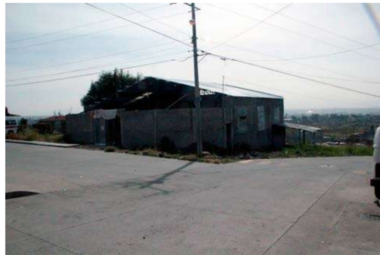
Imagen 33. Templo en proceso de construcción Colonia Loma Colorada Elaboración propia
