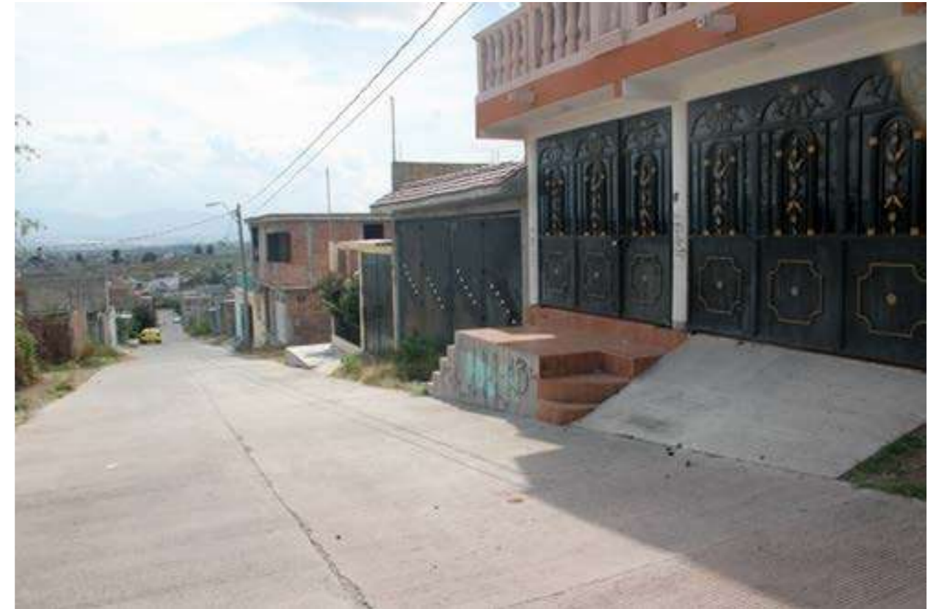
Imagen 31. Vialidad con banquetas inadecuadas Colonia Loma Colorada Elaboración propia
