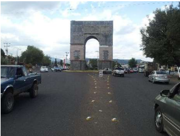
Figura 32. Estación aforadora 77+000 Zac.-Car.
