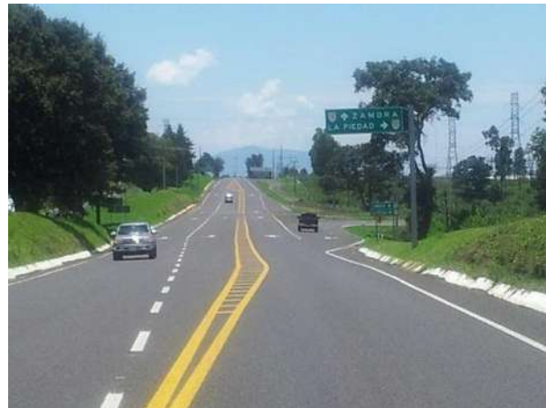
Figura 33. Estación aforadora 105+020 Zac.-Car.
