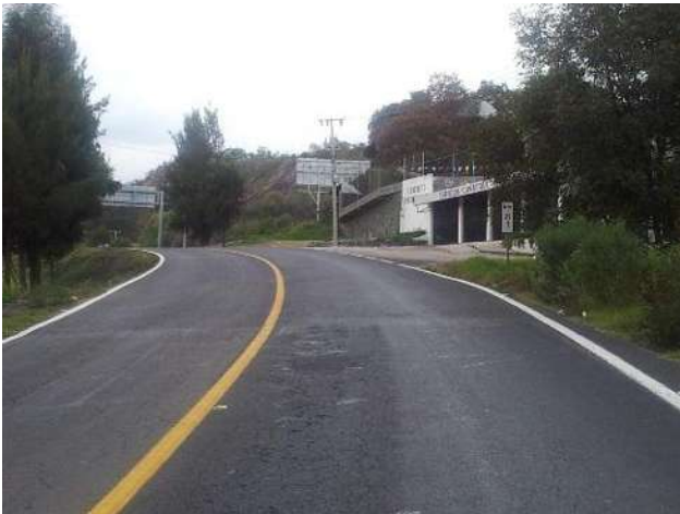
Figura 23. Inicio del tramo Zac.-Car.
