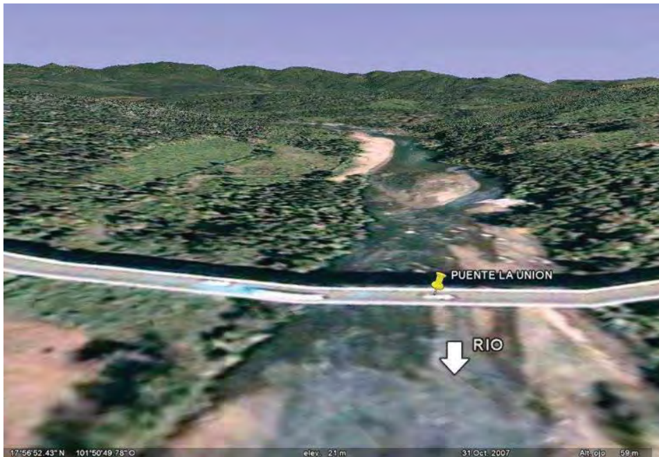
Figura 4.17 Puente la Unión
