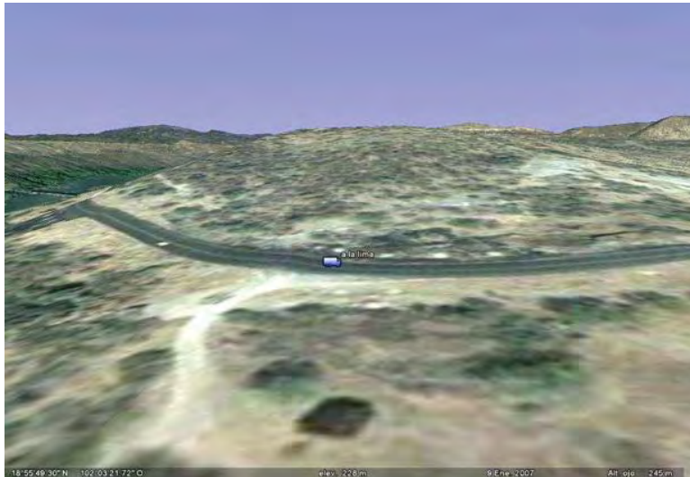
Figura 4.32 Vista del puente A la Lima
