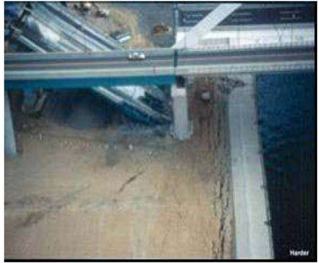
Figura 1.2. Pérdida de longitud de asiento y colapso del acceso del puente de Nishinomiya (Jara, et al, 2006)
