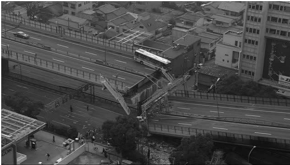
Figura 1.6. Colapso de superestructura por pérdida de longitud de asiento, Japón (Tomada, http://www.gettyimages.com/detail/video/bus-hangs-at-the-edge-of-a-collapsed-highway-overpass-news-footage/502882237 , 2017)
