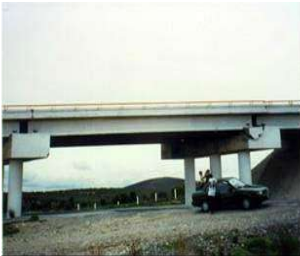
Figura 1.3. Puente esviado con pérdida de longitud de asiento en Puebla, Mexico (Jara, et al, 2006)
