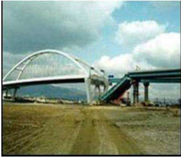
Figura 1.2. Pérdida de longitud de asiento y colapso del acceso del puente de Nishinomiya (Jara, et al, 2006)
