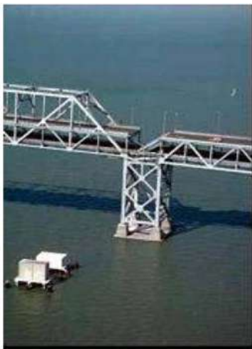
Figura 1.1. Pérdida de longitud de asiento en el puente de San Francisco-Oakland (Jara, et al, 2006)
