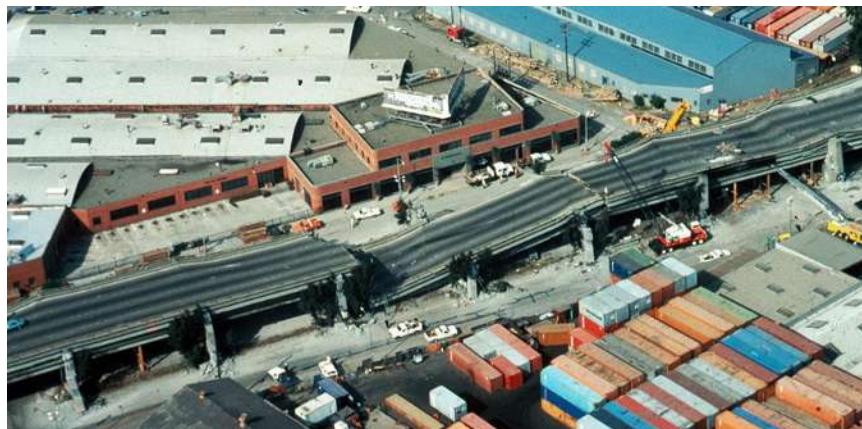
Figura 1.5. Colapso de puente, California (Tomada,
