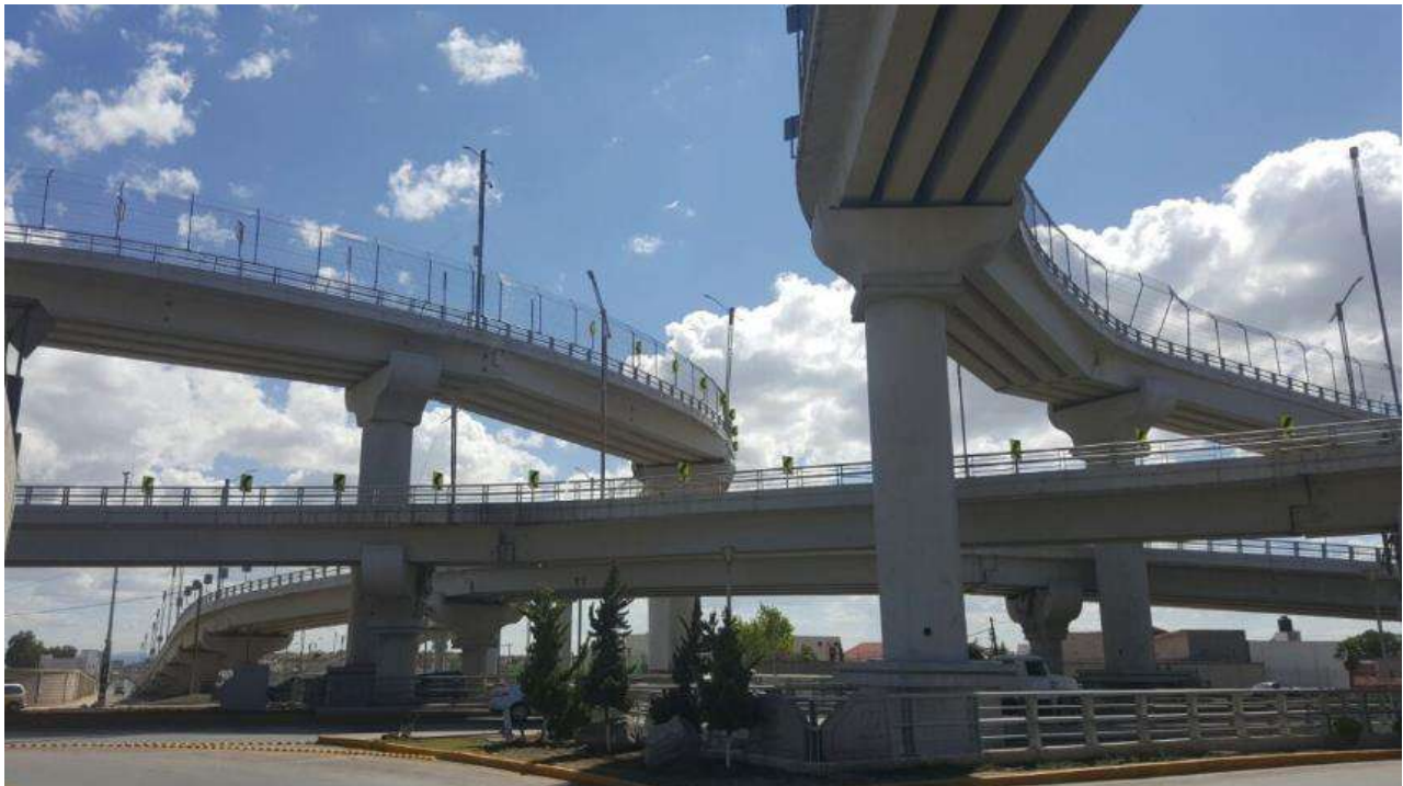
Figura 3.5. Puente Bicentenario con juntas de dilatación intermedias, Pachuca ( http://www.sepsacv.com.mx/wp-content/uploads/2016/12/DISTRIBUIDOR-VIAL-BICENTENARIO-PACHUCA4.jpg , 2017)
