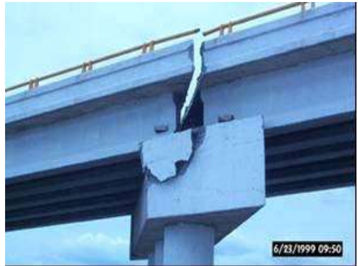
Figura 1.3. Puente esviado con pérdida de longitud de asiento en Puebla, Mexico (Jara, et al, 2006)
