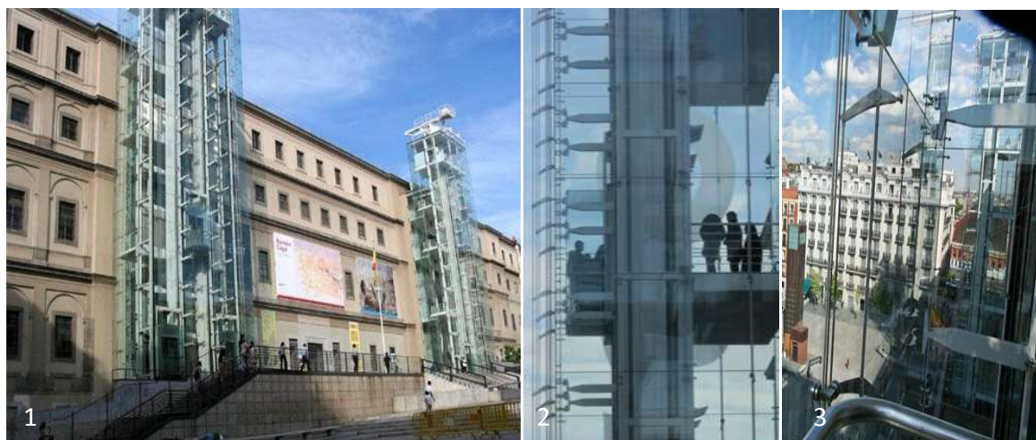
Figura 2.13 Cortinas de vidrio con tensores y cables:
