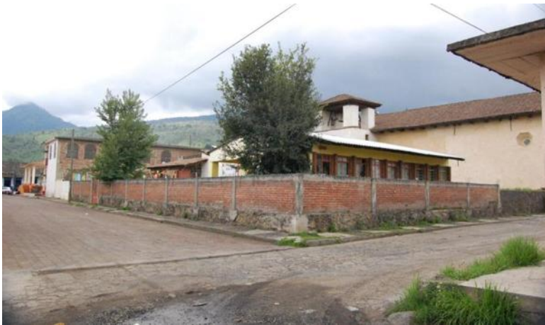
Figura 56.- Espacio en que estuvieron las últimas habitaciones del hospital.
