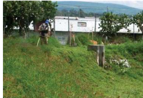
Figura 8. Limpieza del estanque
