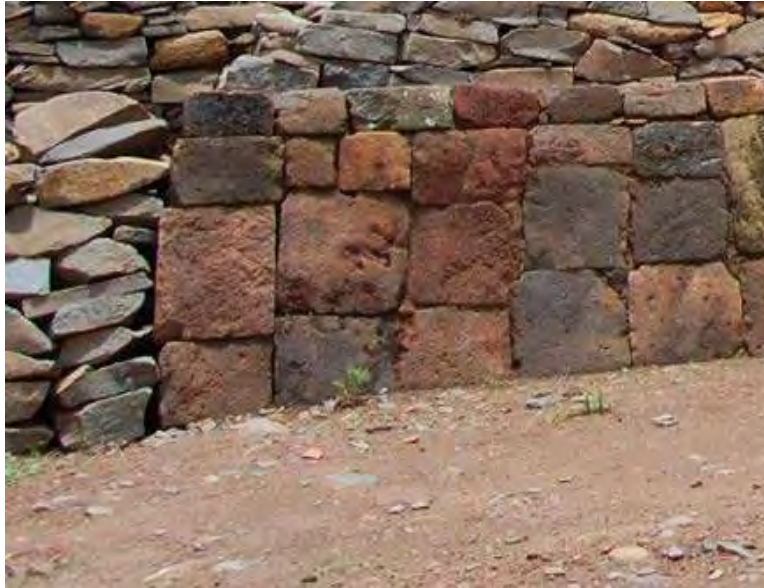
Ilustración 2, Janamus. Esta imagen muestra un cercamiento en donde podemos observar el acomodo de los janamus en donde las piezas se aprecian bien definidas, con trazos firmes, cantos rectos y poca junta.
