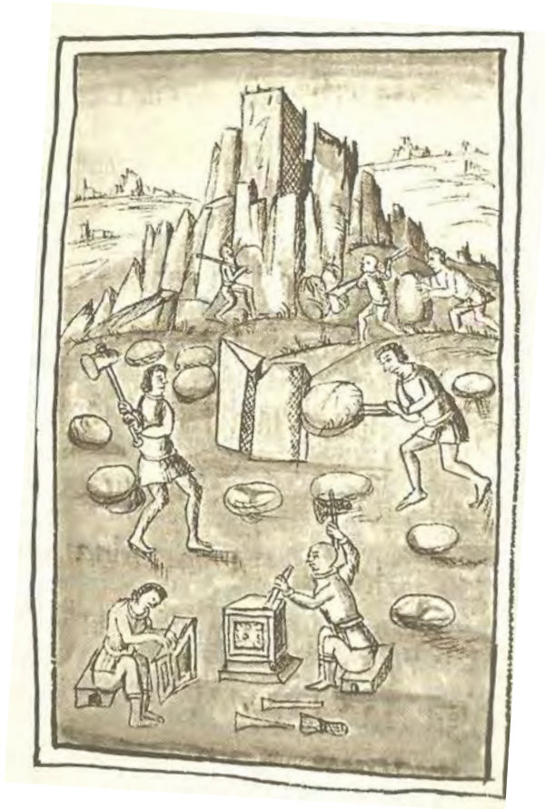
Ilustración 12 Indios Labrando piedras para cantería. Fuente. Fray Bernardino de Sahagún, Códice Florentino, col. Biblioteca Medicea Laurenziana; Florencia Italia. Tomado de Roberto Meli, Los Conventos Mexicanos del siglo XVI, Construcción, Ingeniería estructural y conservación , México, UNAM, p.75
