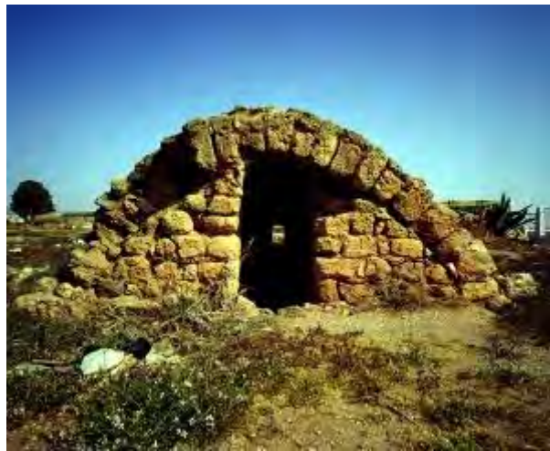
Ilustración 7. Fachada del aljibe de Bermejo. En el cual podemos apreciar los sillares en fachada, Fuente: http://almeriapedia.wikanda.es/wiki/Aljibe_Bermejo_de_Campohermoso_(N%C3%ADjar)
