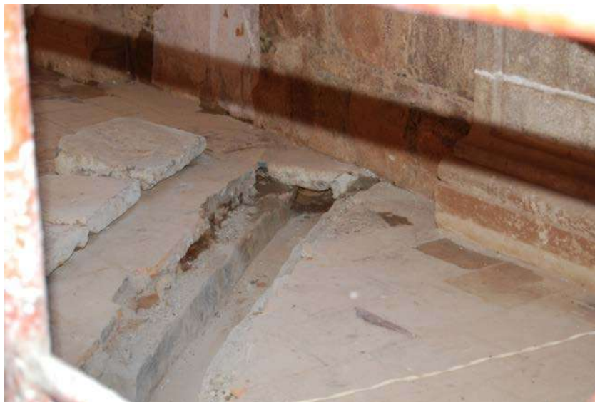
Ilustración 18. Punto de recolección de agua pluvial del claustro en el convento de Tzintzuntzan.
