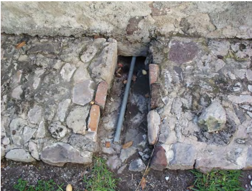
Ilustración 16 canales de conducción de mampostería, en el convento de Cuitzeo Fuente: Foto tomada por la autora
