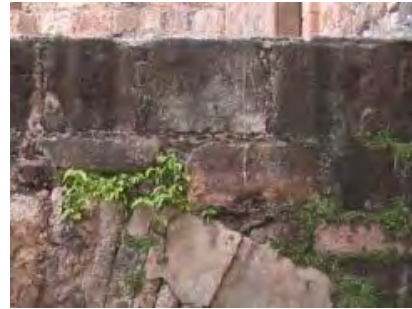
Ilustración 8. Rejoneo en muro de mampostería en el aljibe.
