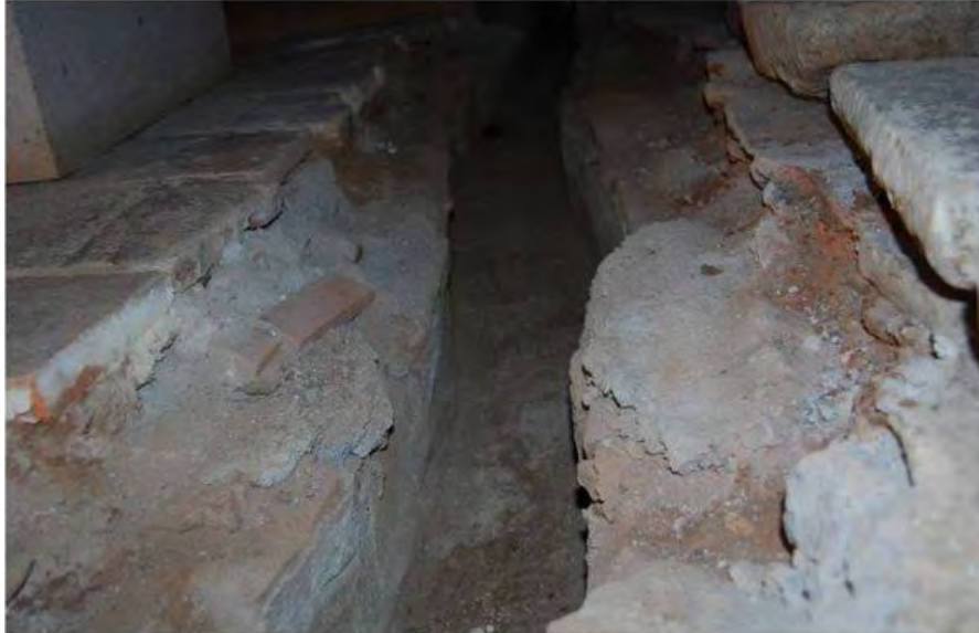
Ilustración 17. Imagen de canales de conducción del Convento Franciscano de Tzintzuntzan Fuente: Foto tomada por el autor.
