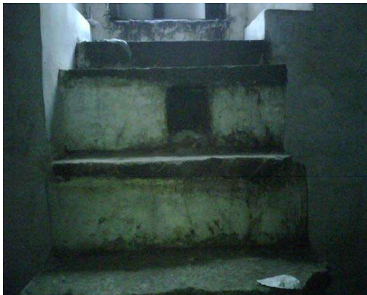
Ilustración 14. Punto de desemboque en el interior del aljibe. Fuente: foto tomada por la autora el 28 de mayo de 2009.
