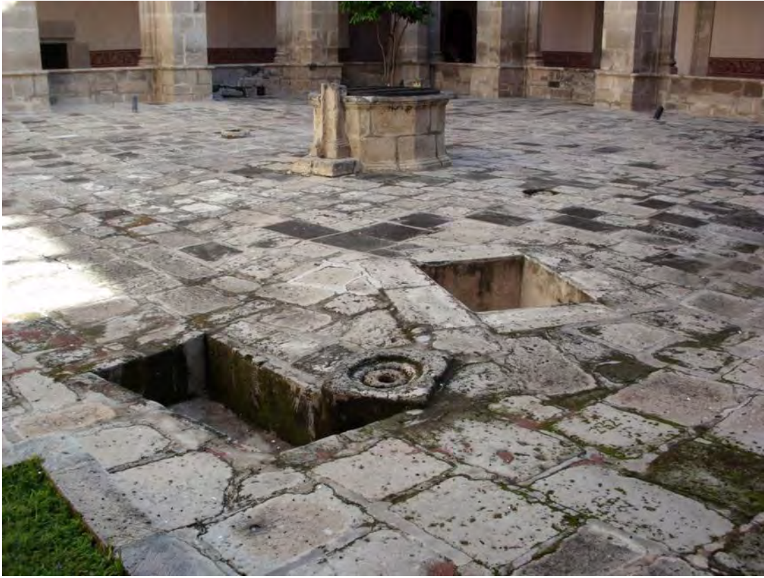
Ilustración 22 Aljibe y trampas o depósitos de filtración del convento Santa María Magdalena en Cuitzeo.
