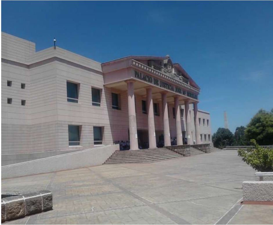
fachada del lado posterior del edificio,
