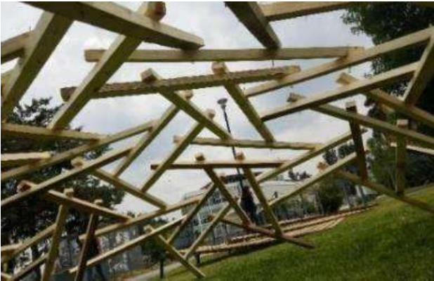
Figura 83 Cubierta de madera con grapas de galvanizado utilizando como base geométrico un hexágono:
