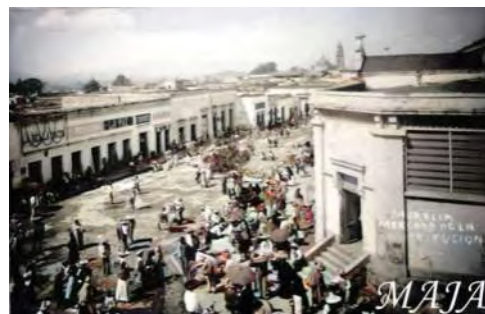
Figura V.7.- Fotografía del cruce de la calle Fray Juan de San Miguel y Humboldt. Fuente: Morelia a través del tiempo
