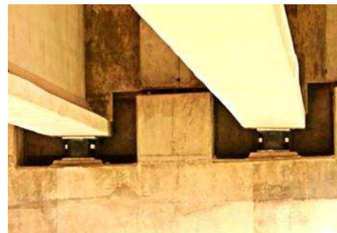
Figura 5.15. Reconstrucción del Rio Claro en Chile, se realizó sentando la superestructura en apoyos flexibles ( http://rba-global.com/proyectos/puente-rio-claro/ ).
