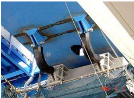
Figura 5.22 Se muestra la instalación del sistema "Znoidal" de forma de herradura ( http://www.bridgestone.com/products/diversified/antiseismic_rubber/other_products.html )
