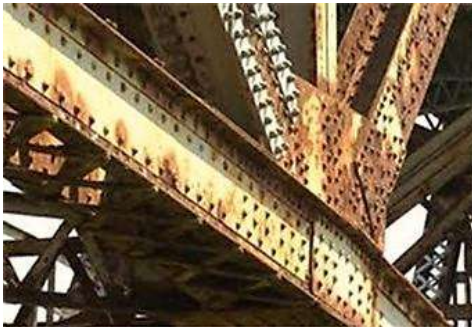
Figura 3.18. Se presenta la corrosión en las uniones de las armaduras afectando gravemente la resistencia y la vida útil del puente ( http://www.wthitv.com/news/local/sr-46-bridge-to-re-open-in-november ).
