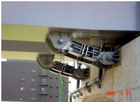
Figura 5.23 Dispositivo de protección sísmica tipo múltiples pistones "izquierda" ( http://camelliajapónica.web.fc2.com/kobe/portliner/movingwalk01/movingwalk01.htm ) y un solo pistón "derecha" (State of art report, 2007)
