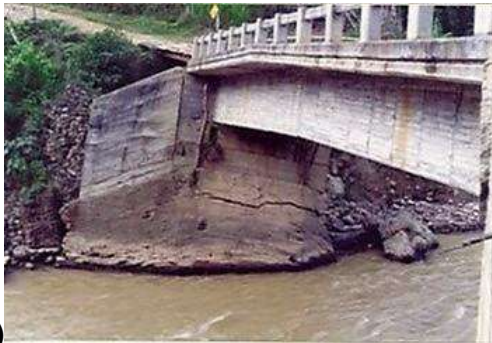
Figura 3.19. a) En los puentes con esviamiento, es común la socavación parcial produciéndose un mecanismo de falla por torsión, (Hec-18, 2001). b) La pérdida de material de suelo en el apoyo intermedio de las pilas (Jorge Molina, 2001).
