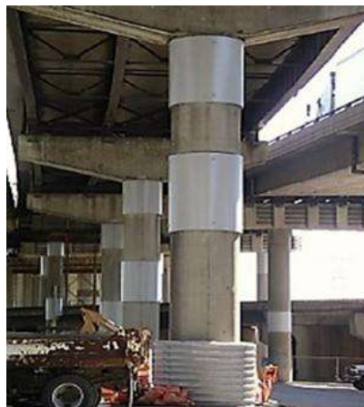
Figura 5.4. La rehabilitación de las columnas del puente mediante encamisados de acero (Reginald DesRoches, 2008).
