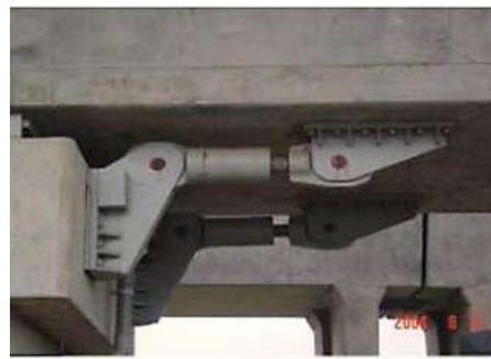
Figura 5.23 Dispositivo de protección sísmica tipo múltiples pistones "izquierda" ( http://camelliajapónica.web.fc2.com/kobe/portliner/movingwalk01/movingwalk01.htm ) y un solo pistón "derecha" (State of art report, 2007)
