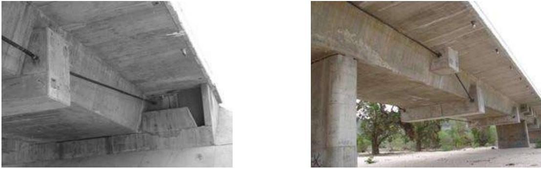
Figura 4.2. Rehabilitación del puente Motín de Oro, utilizando la técnica de presfuerzo externo (Jara J.M y Jara M., 2010).
