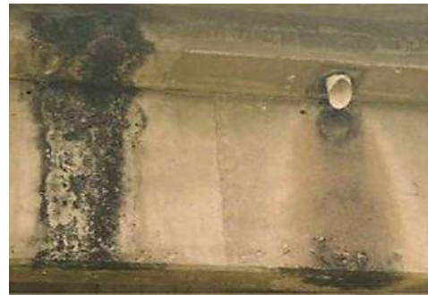
Figura 3.15. La presencia de la humedad en el alma de la trabe de un puente causados por la falta de drenes generando pérdida de resistencia (Jara J.M. y Jara M. 2010).
