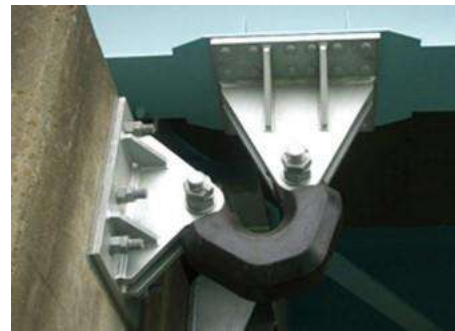
Figura 5.22 Se muestra la instalación del sistema "Znoidal" de forma de herradura ( http://www.bridgestone.com/products/diversified/antiseismic_rubber/other_products.html )
