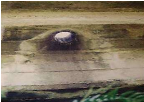
Figura 3.15. La presencia de la humedad en el alma de la trabe de un puente causados por la falta de drenes generando pérdida de resistencia (Jara J.M. y Jara M. 2010).
