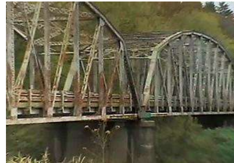
Figura 3.18. Se presenta la corrosión en las uniones de las armaduras afectando gravemente la resistencia y la vida útil del puente ( http://www.wthitv.com/news/local/sr-46-bridge-to-re-open-in-november ).
