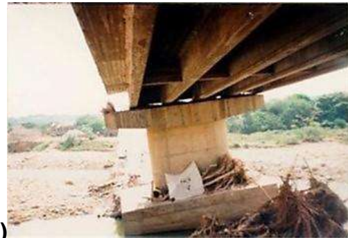
Figura 3.19. a) En los puentes con esviamiento, es común la socavación parcial produciéndose un mecanismo de falla por torsión, (Hec-18, 2001). b) La pérdida de material de suelo en el apoyo intermedio de las pilas (Jorge Molina, 2001).
