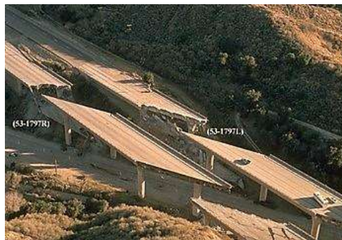
Figura 3.9. Se generó la pérdida de asiento del puente Gavin Canyon, durante el sismo de Northridge en 1994 ( http://stone-fusion.com/gavin%20failure%20images.htm ).
