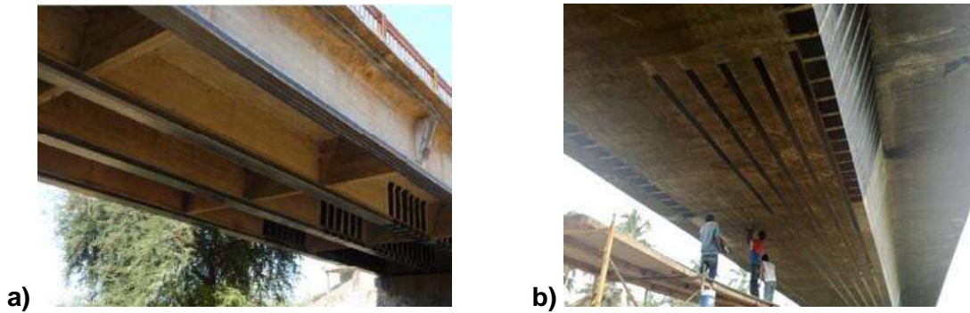
Figura 4.22. El reforzamiento a flexión y a cortante de los puentes a) Cutzamala y b) puente de sección cajón (Construcción Sika, 2007).
