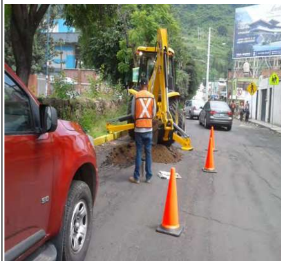
Sondeos en vialidad para determinar estratigrafías
