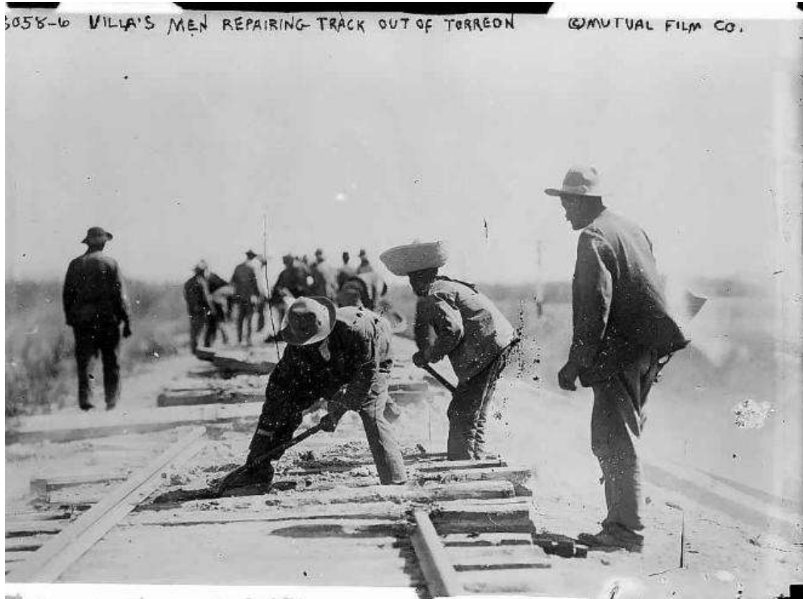
Figura 2.16 Hombres de Villa Reparando las vías en las afueras de Torreón. Fuente: http://catarina.udlap.mx/
