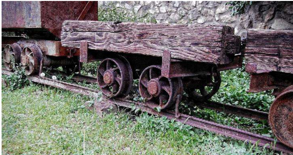
Figura 2.2 Antiguas vagonetas mineras. Fuente: http://es.wikipedia.org/
