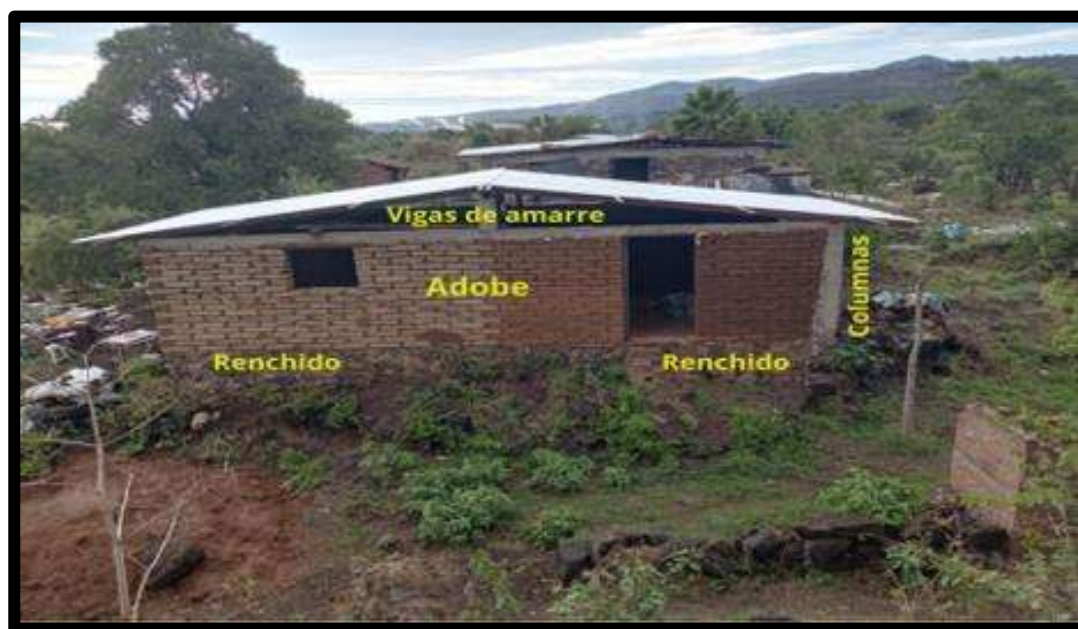
Figura 39. Técnicas de construcción Casita Comunal
