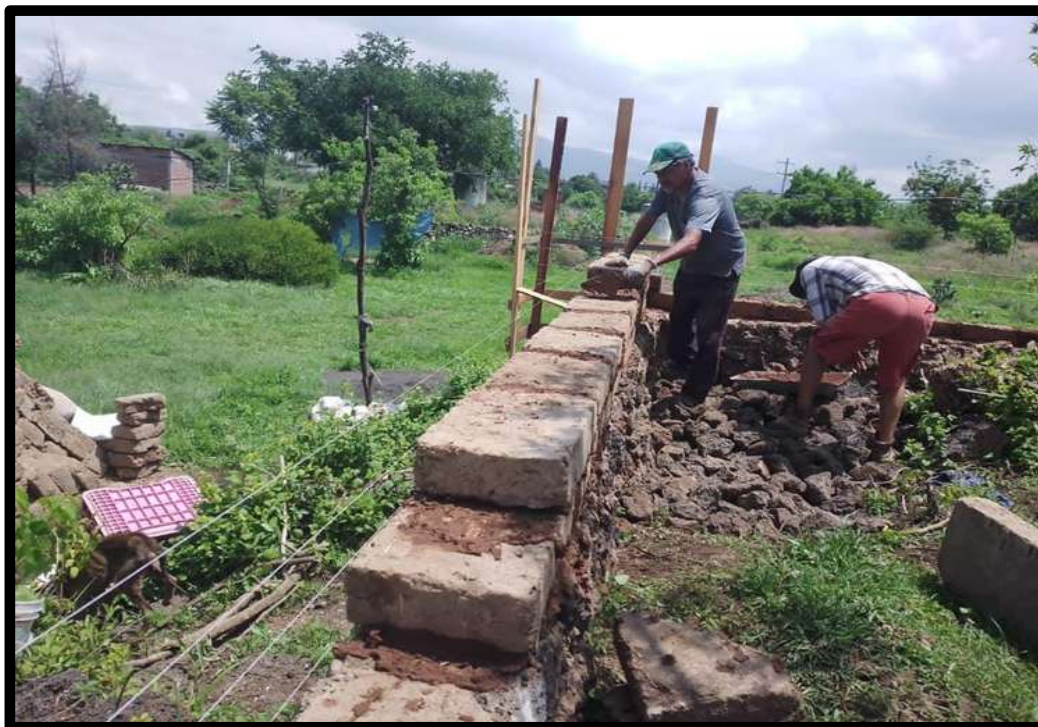
Figura 37. Proceso de pegado del adobe en la construcción Nueva Casita Comunal CEJM
