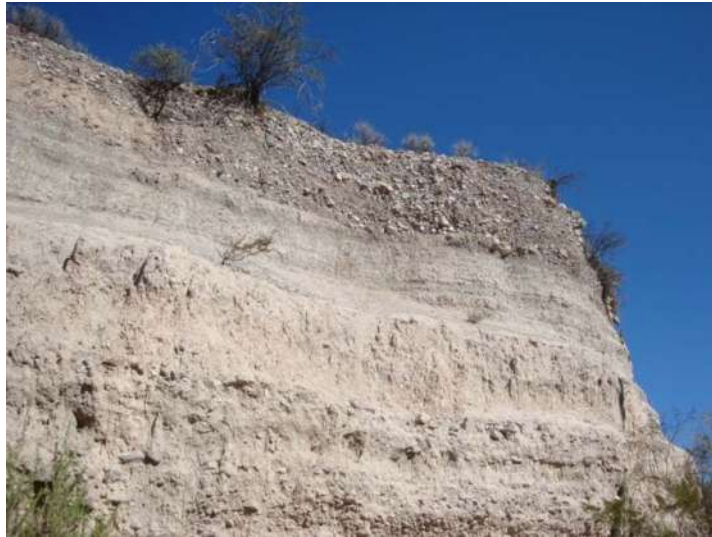
Figura 38. Sección del arroyo Ojo de Agua ubicada a 200m de la columna tipo; en la parte superior se aprecia el aluvión que en varios transectos se ha erosionado.
