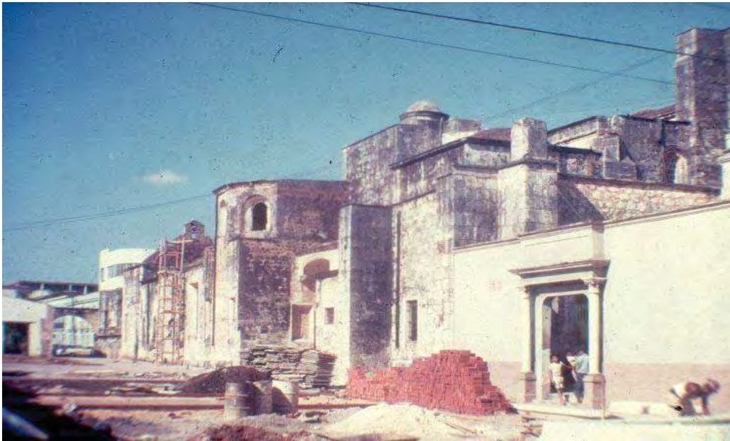
Foto 104. Trabajos realizados durante el rescate de la Plazoleta de los Curas, 1971. También se puede observar parte de la edificación que se construyó en 1917, la cual se demuele en el 1971.
