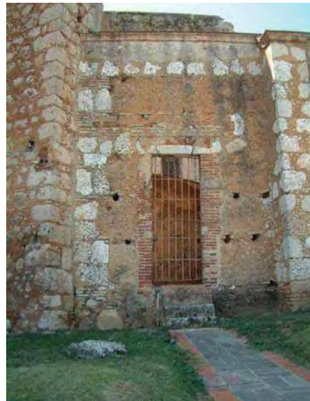
Foto 44. Entrada lateral que va hacia la Sacristía.
