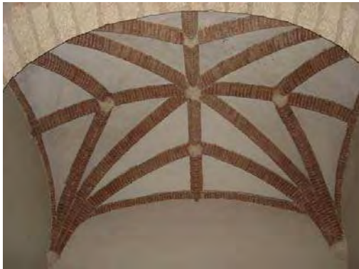
Foto 62a. Bóveda de crucería de una de las capillas.
