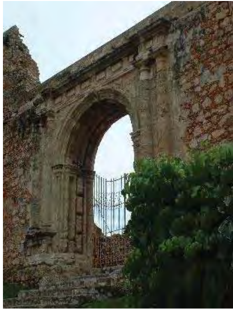
Foto 41. Fachada principal de la iglesia del Monasterio de San Francisco.
