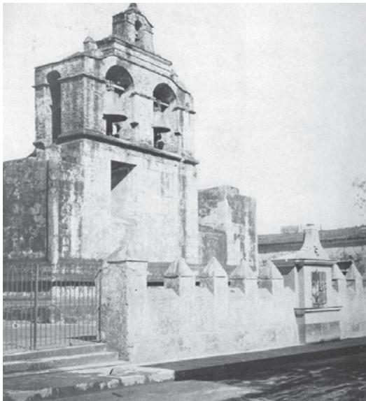
Foto 126. Foto antigua del campanario de la Catedral , el cual en ese momento tenía enlucido en las obras de ladrillo.
