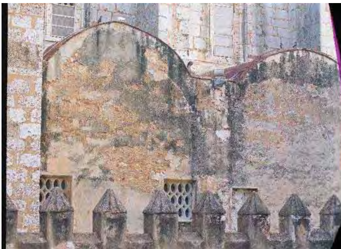
Foto 198. Muro de tapia en capillas laterales del lado norte.
