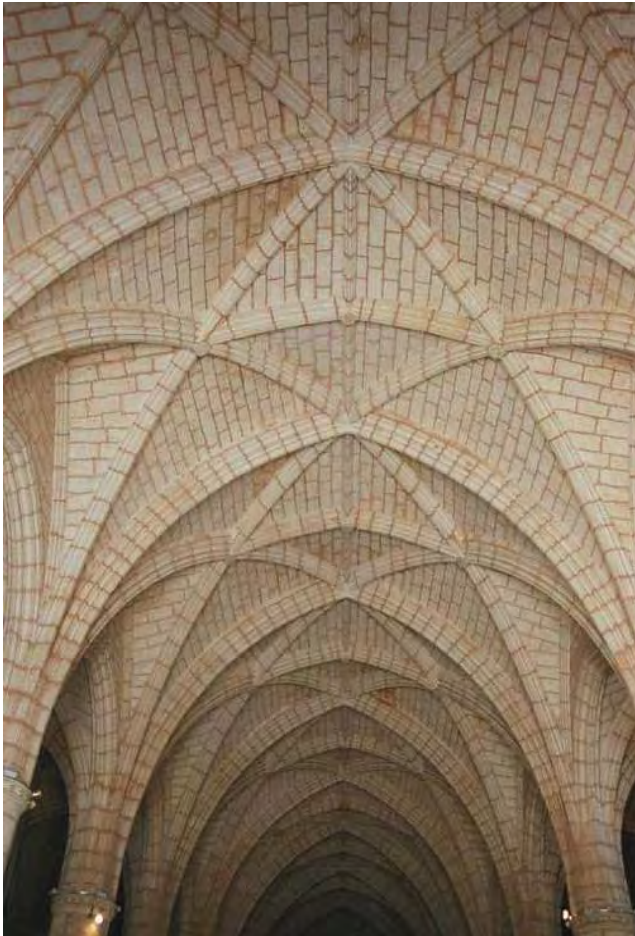
Foto 210. Bóveda de la nave central de la Catedral. En el abovedamiento de la Catedral de Santo Domingo presenta a todo lo largo de su bóveda central un nervio longitudinal en el que se van enlazando las claves de los arcos diagonales y perpiaños, y que no se justifica como apoyo de la plementería ni recibe carga alguna. Se observa claramente como los plementos están colocados paralelos al nervio longitudinal.
