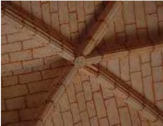
Foto 209. Disposición de la plementería de las bóvedas de la Catedral de Santo Domingo.
