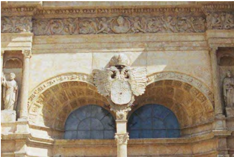
Foto 114. Arcos abocinados en la fachada de la Catedral de Santo Domingo. Estos arcos están conformados por arquivoltas enviajadas.
