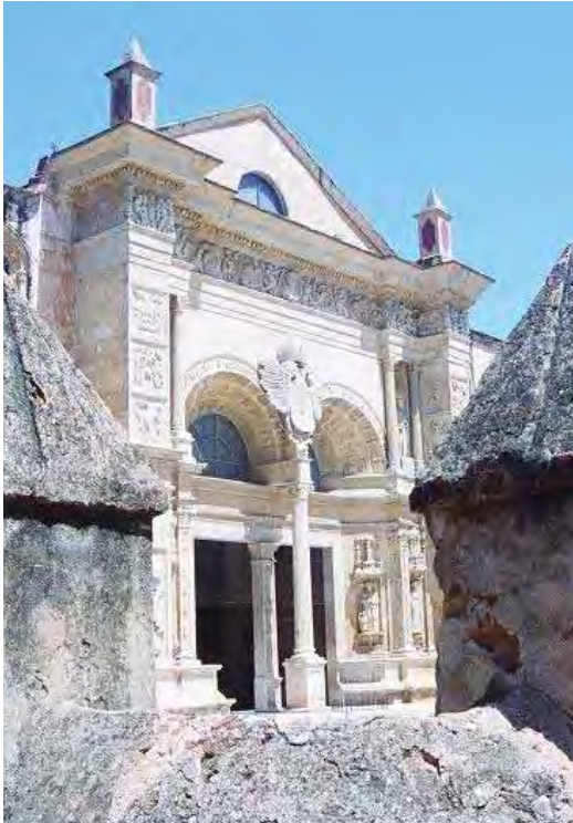
Foto 111. Fachada de la Catedral de Santo Domingo. Fuente: EPV, 2006
