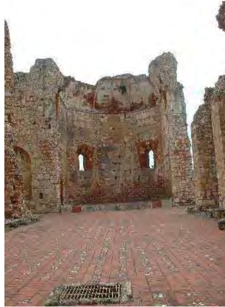
Foto 42. Interior de la iglesia del Monasterio de San Francisco.
