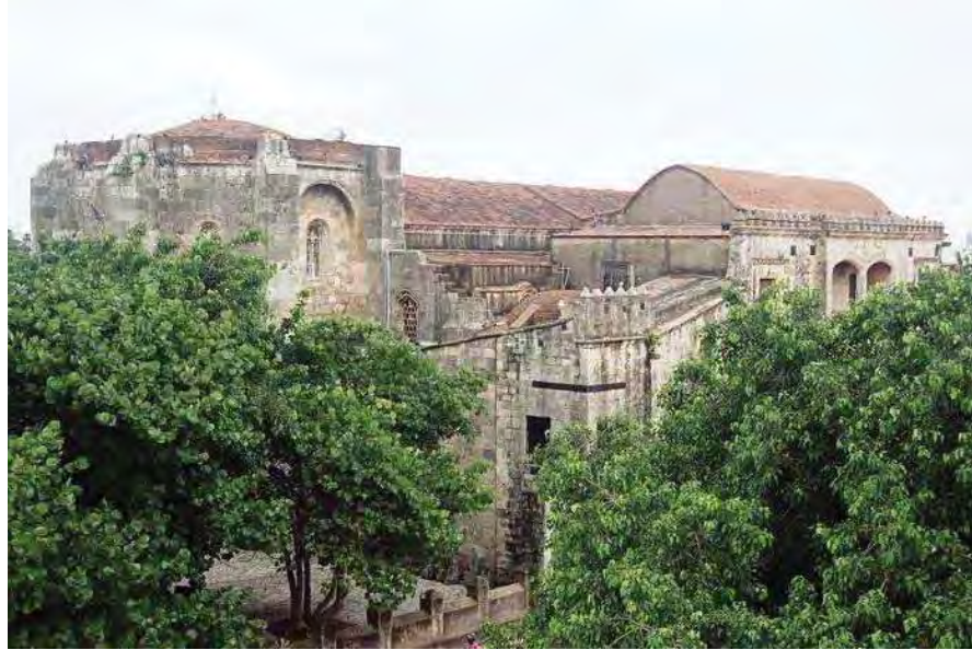
Foto 108. Catedral vista desde el noreste. Se puede apreciar el ábside, el cabildo y parte de sus techos.
