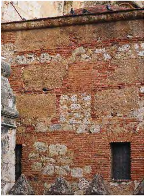
Foto 202. Muros de tapia real, en las capillas del lado norte. Fuente: VFS, 2004
