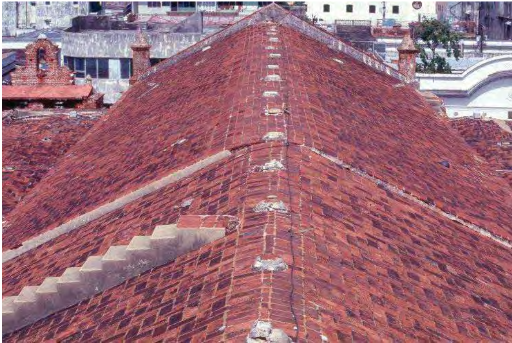
Foto 206. Cubierta de la nave central de la Catedral. Se puede apreciar claramente la colocación de los ladrillos.
