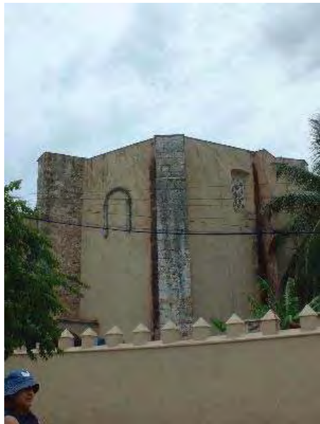
Foto 58. Ábside ochavado visto desde el exterior.
