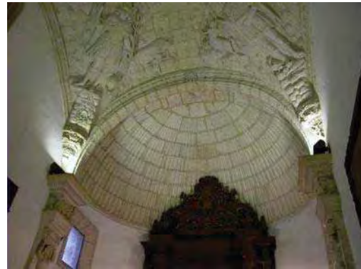
Foto 62b. Bóveda de piedra de una capilla lateral.
