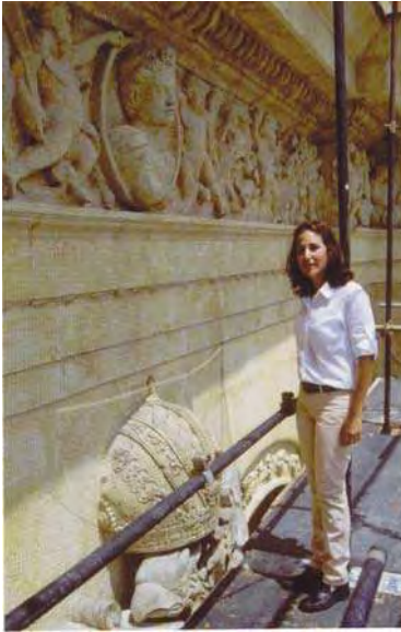
Foto 106. Trabajos de mantenimiento en la fachada de la Catedral.
