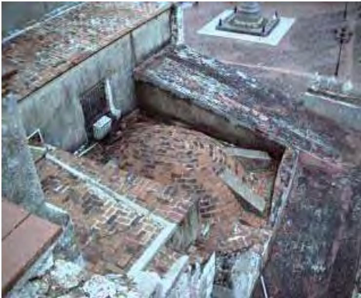
Foto 217. Cubiertas de las capillas del lado Norte. Las cubiertas están hechas de ladrillos unidos con argamasa directamente a las bóvedas de piedra, cosa muy usual y común en todas las iglesias coloniales construidas en esos momentos.
