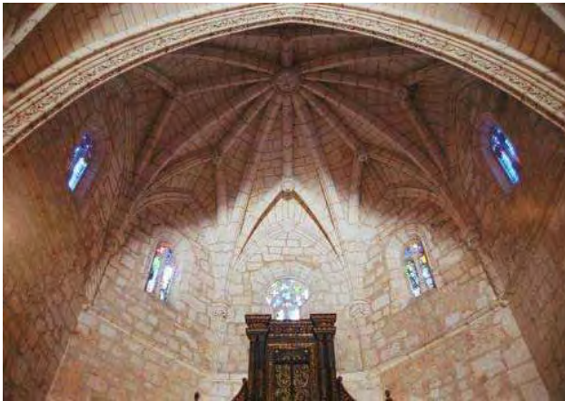
Foto 136. Capilla Mayor. Se puede observar el Arco de Triunfo, la bóveda de la capilla mayor y las 5 ventanas que están en el ábside.
