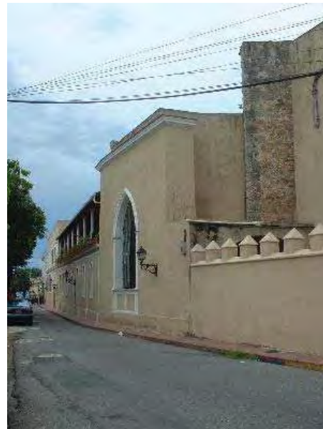
Foto 59. Sacristía vista desde el exterior y puerta de acceso al convento.
