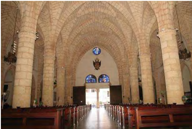
Foto 78. Interior de la Catedral. Vista hacia el Oeste. Se observan las bóvedas de crucería.
