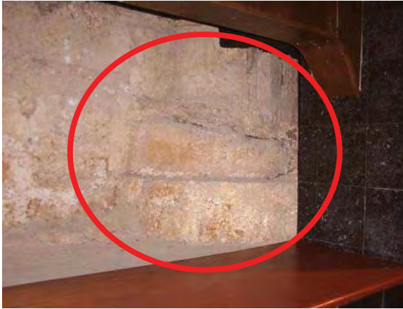
Foto 190. Cimientos del ábside. Parte superior de los cimientos del ábside en donde se puede observar el arranque de la columna adosada que soporta el arco de triunfo de la capilla Mayor.
