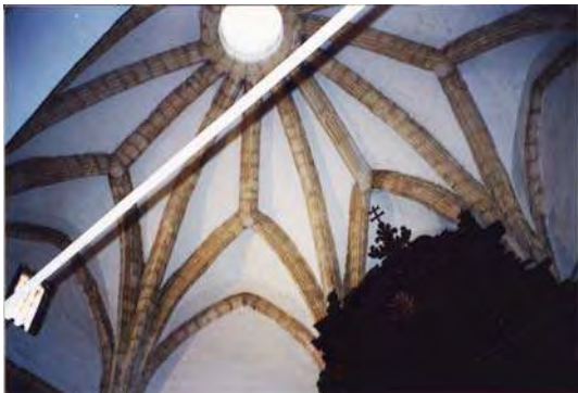
Foto 55a. Interior de la bóveda de la Iglesia de Santa Bárbara.
