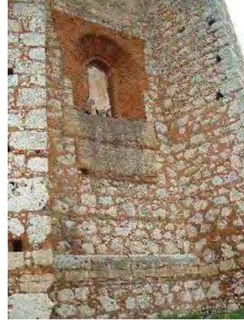
Foto 45b. Muros del ábside de la iglesia de San Francisco.
