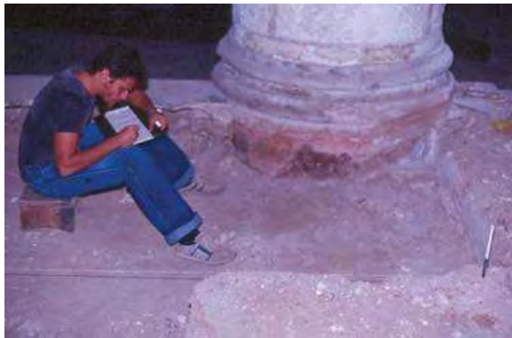
Foto 189. Cimiento en una de las columnas de la nave central.
