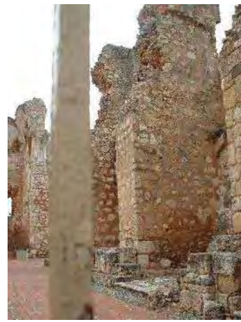
Foto 45d. Capillas laterales, ubicadas dentro de los contrafuertes, en la iglesia de San Francisco.
