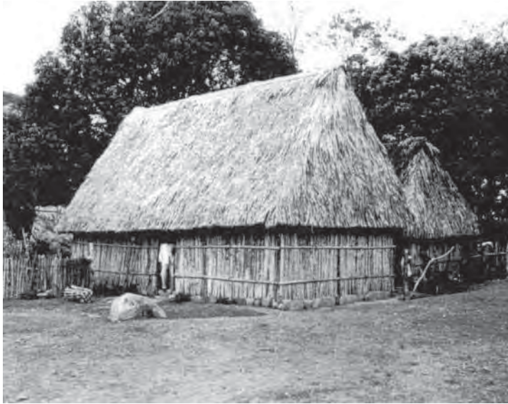
Foto 36. Actual vivienda indígena en Veracruz. Ubicada en la cuenca del Papaloapan en Veracruz, de planta rectangular construida de pequeños troncos de árboles y con techo de paja.
