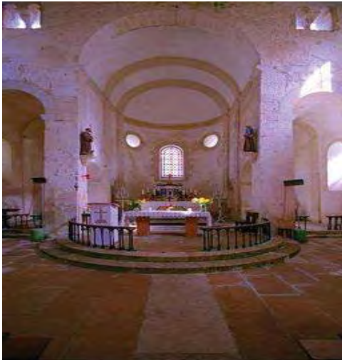
Foto 180. Iglesia de Saint Genéroux, Francia. Su construcción es de la primera etapa del románico que se caracterizó por muros de sillería más bien pequeña, con piedras obtenidas simplemente a golpes de martillo y dispuesta en hileras bastante regulares para imitar los aparejos antiguos.
