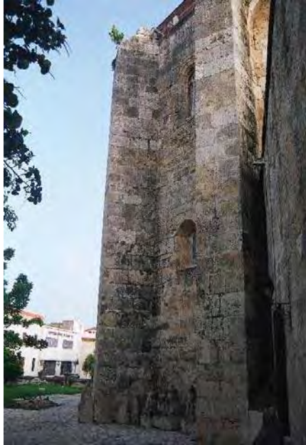
Foto 195 (a,b). Contrafuertes del ábside de la Catedral de Santo Domingo. Fuente: VFS, 2004
