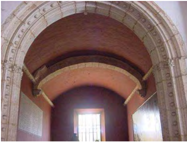
Foto. 97. Capilla de San Pedro. Se puede observar en su bóveda las dos partes en que estuvo dividida.
