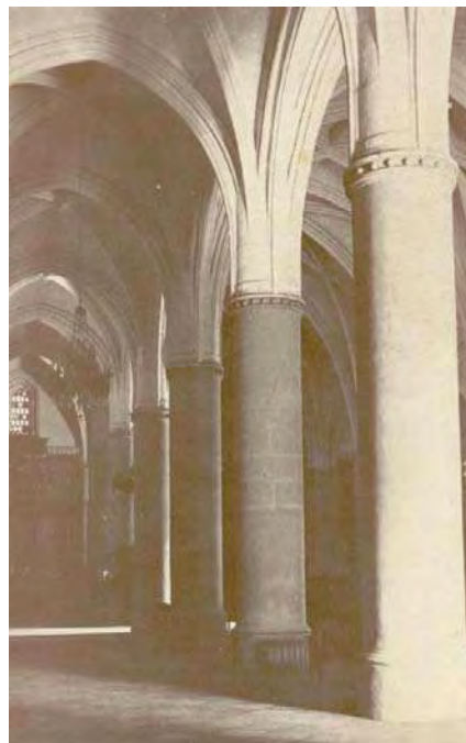
Foto 103. Columnas en el interior de la Catedral en 1950, todavía con su enlucido original.
