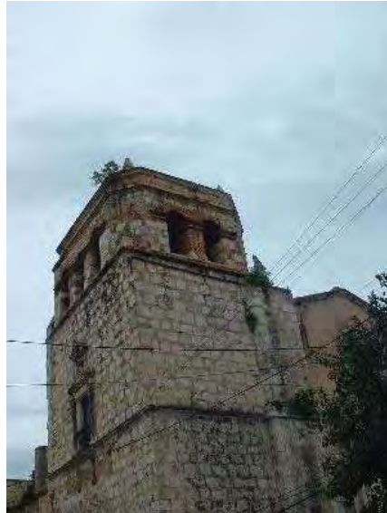
Foto 64a. Torre del campanario del convento de las Mercedes.
