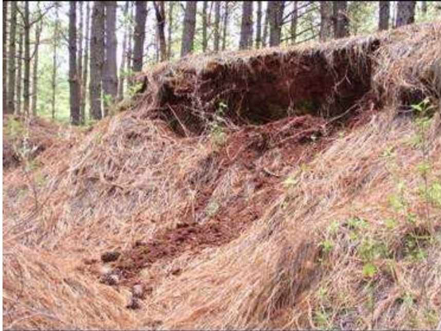
Figura 5.2.6. Erosión por desprendimiento en las cabeceras de cárcavas bajo una reforestación de pinos en la cuenca de Cuitzeo, Michoacán.
