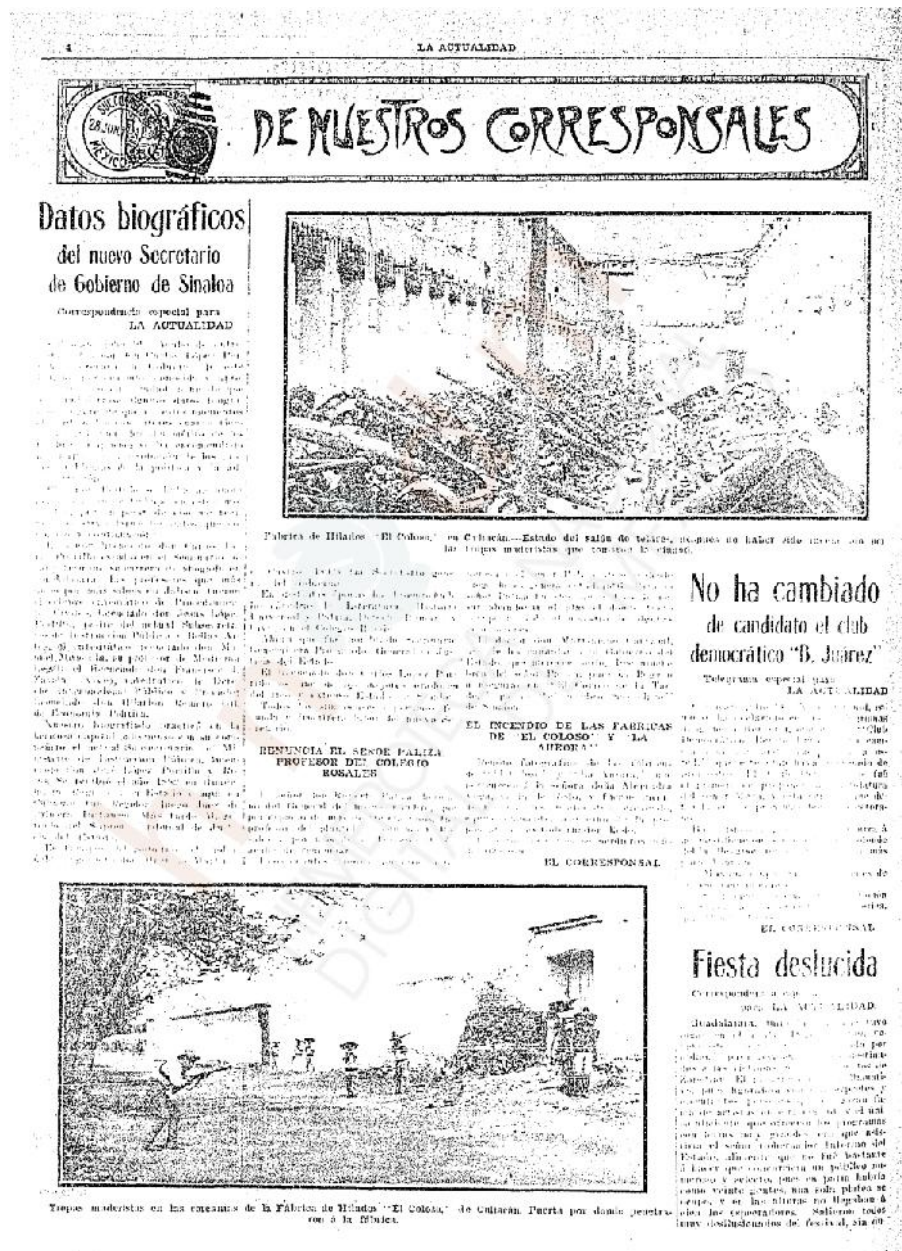
66. "Fábrica de hilados El Coloso en Culiacán" y "tropas maderistas en las cercanías de la Fábrica de Hilados "El Coloso" de Culiacán. Puerta por donde penetraron a la fábrica". La Actualidad , México, 16de julio de 1911 (Hemeroteca Nacional Digital de México).
