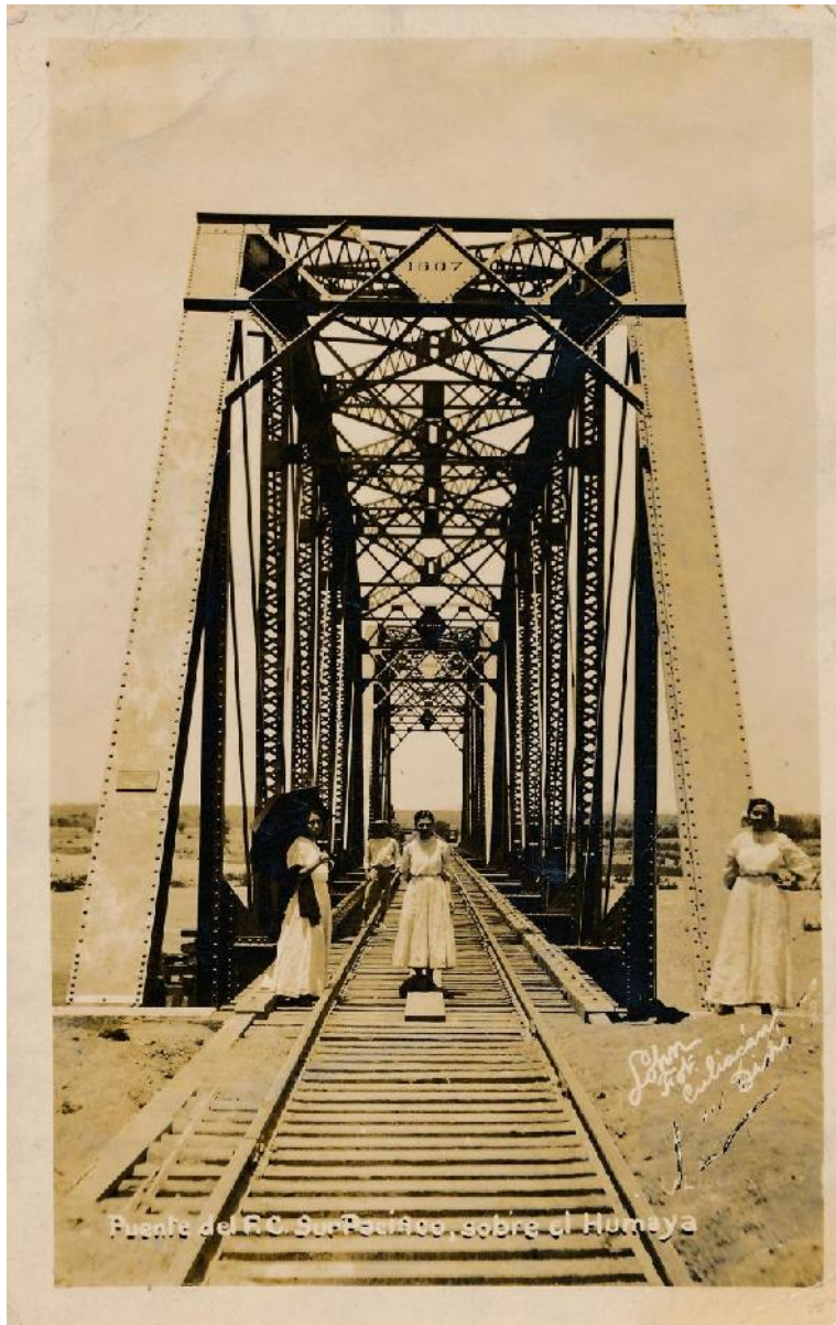
5. Puente del F.C. Sud Pacífico sobre el Humaya. Lohn Fot., Culiacán, Sinaloa (Cortesía William F. Manger).
