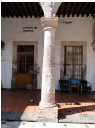
Imagen 29 Detalle de columna toscana.
