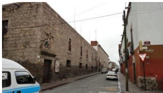
Imagen 12 Cableado aéreo del servicio telefónico.
