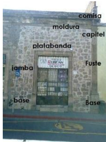
Imagen 24 Detalle de composición de vano en accesorias.
