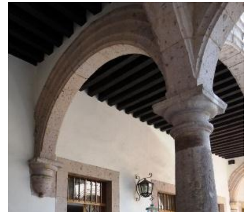
Imagen 31 Detalle de consola.
