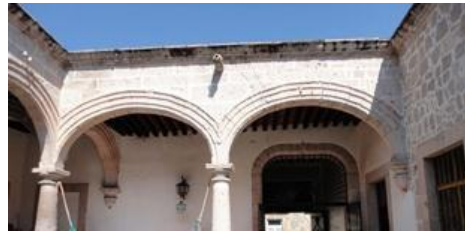
Imagen 26 Arquería pasillos norte sur, arcos de tres puntos.
