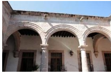
Imagen 27 Arquería pasillos oeste, arcos de medio punto.
