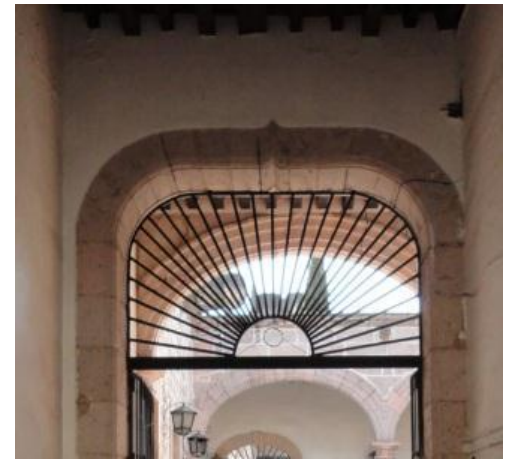
Imagen 25 Detalle de arco deprimido.
