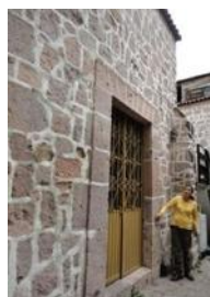
Imagen 35 Puerta de acceso a la cocina.
