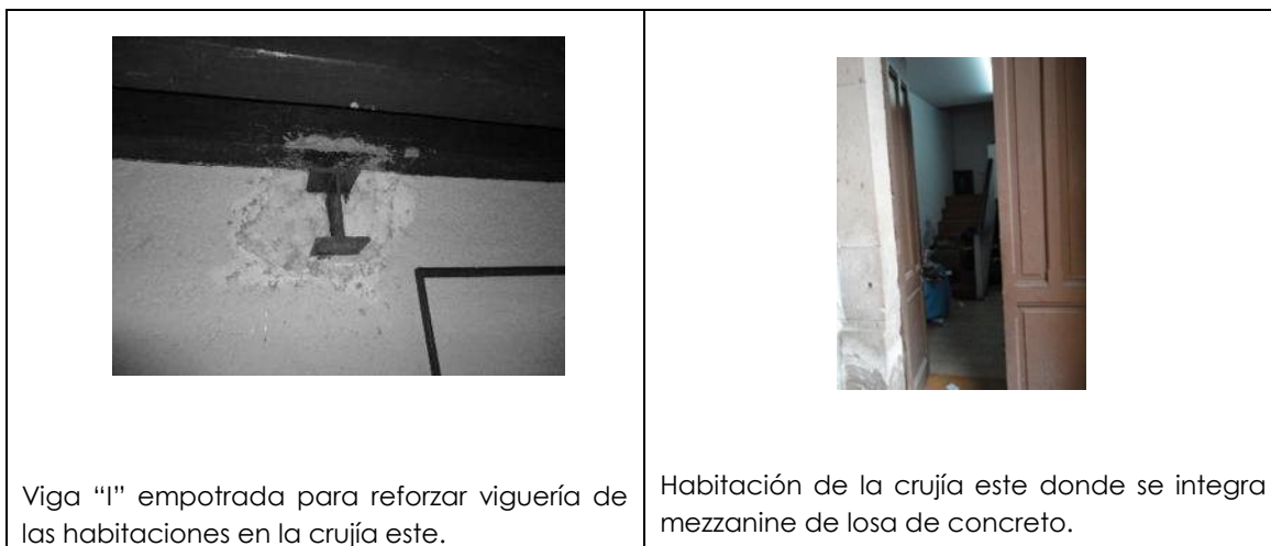
Imagen 21 Detalles de modificaciones estructurales
