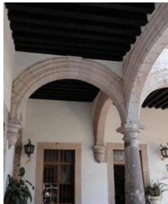
Imagen 30 Detalle de arco de rincón de claustro.
