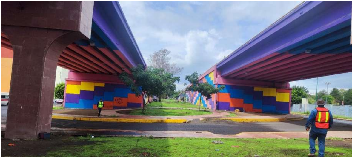
Figura IV.3: Puente La Central (inicio del tramo con dirección Quiroga-Salamanca)
