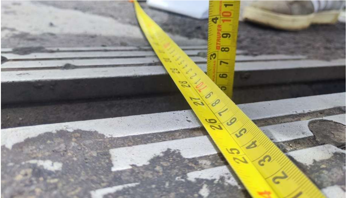
Figura IV.21: Espesor de Reencarpetamiento en puente Pedregal
