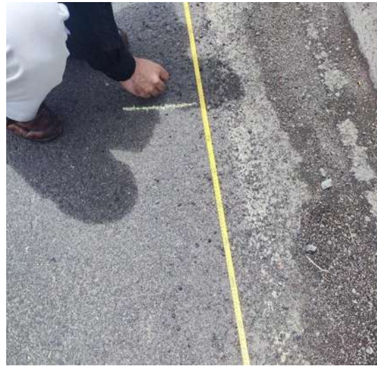
Figura IV.43: Marcado de ubicaciones donde se colocarán los sensores de la primera configuración
