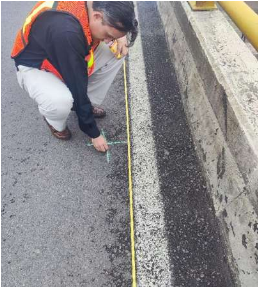
Figura IV.38: Marcado de ubicaciones donde se colocarán los sensores de la primera configuración
