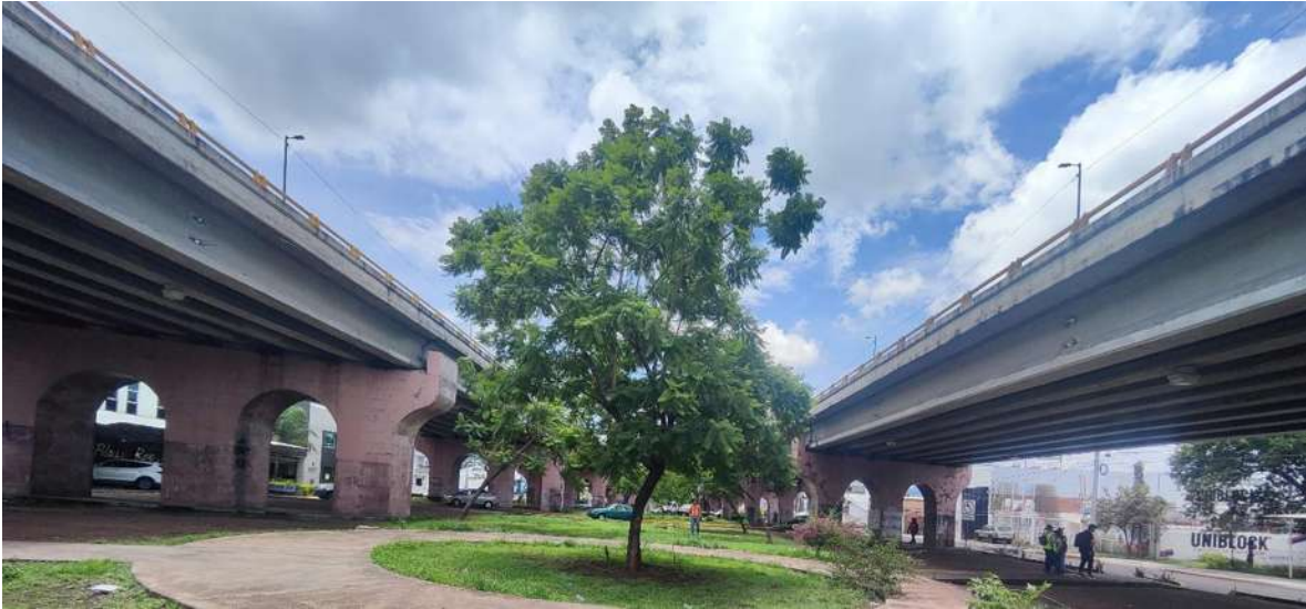
Figura IV.23: Puente El Lago (inicio del tramo con dirección Quiroga-Salamanca)
