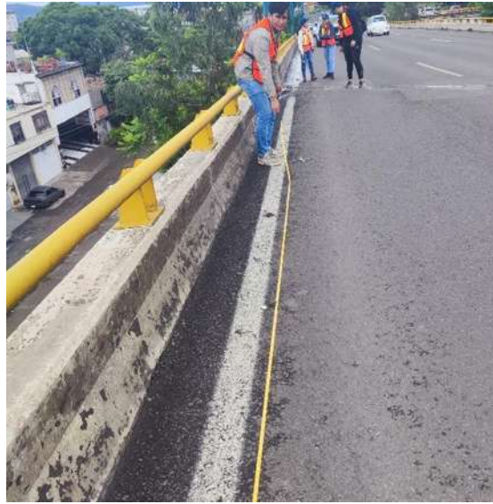
Figura IV.38: Marcado de ubicaciones donde se colocarán los sensores de la primera configuración
