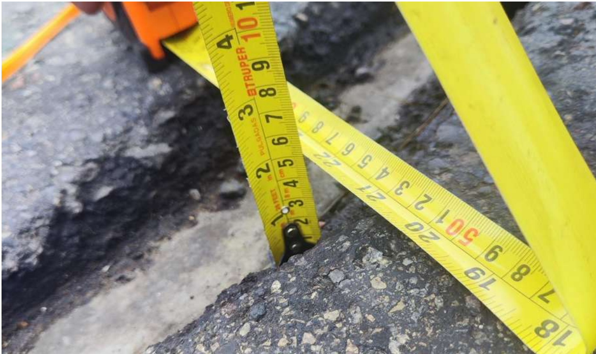
Figura IV.30: Espesor de Reencarpetamiento en puente El Lago
