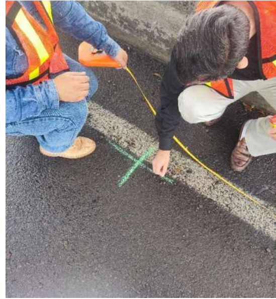
Figura IV.33: Marcado de ubicaciones donde se colocarán los sensores de la primera configuración
