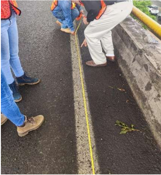
Figura IV.33: Marcado de ubicaciones donde se colocarán los sensores de la primera configuración
