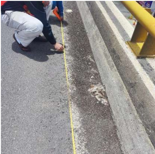
Figura IV.43: Marcado de ubicaciones donde se colocarán los sensores de la primera configuración
