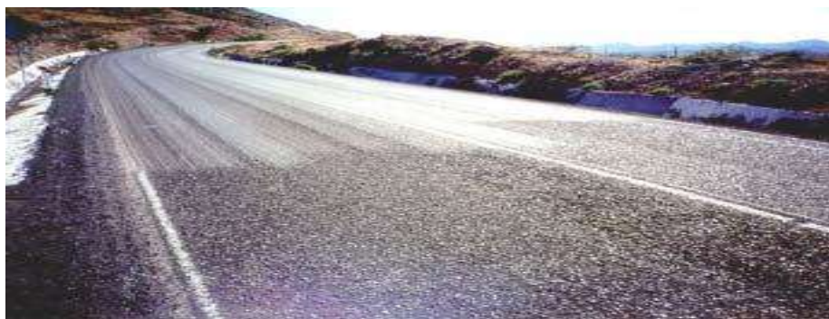
Ilustración 35.- Exposición de agregados (CONSEJO DE DIRECTORES DE CARRETERAS, 2002)
