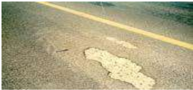
Ilustración 30.- Desprendimiento de agregados (calaveras o surcos) (CONSEJO DE DIRECTORES DE CARRETERAS, 2002)
