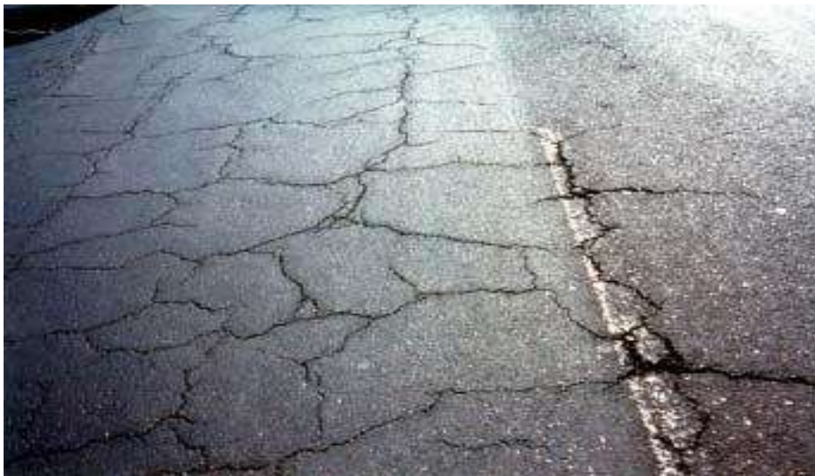
Ilustración 42.- Fisuras solas o en retícula (malla) (CONSEJO DE DIRECTORES DE CARRETERAS, 2002)
