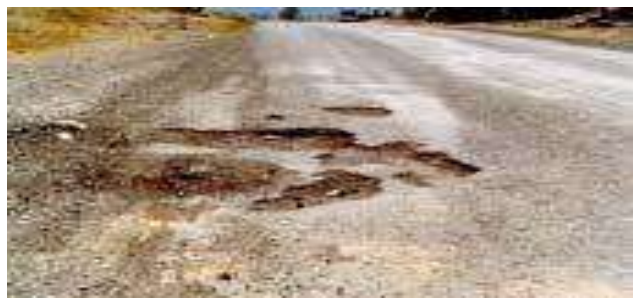
Ilustración 30.- Desprendimiento de agregados (calaveras o surcos) (CONSEJO DE DIRECTORES DE CARRETERAS, 2002)
