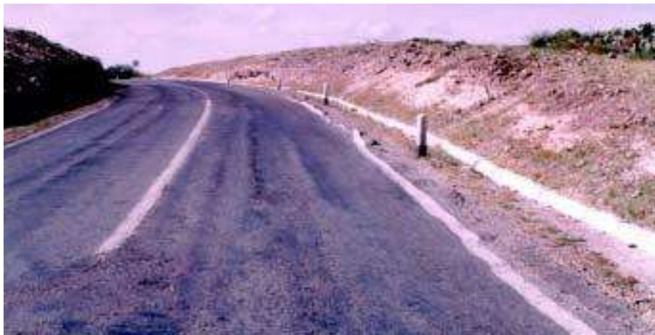
Ilustración 37.- Canalizaciones (CONSEJO DE DIRECTORES DE CARRETERAS, 2002)
