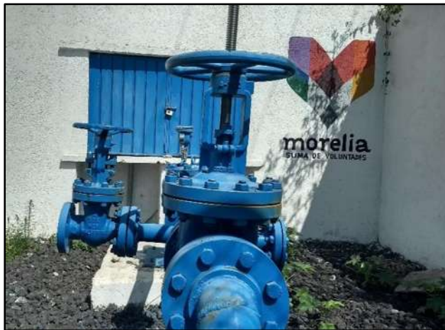
Figura 17. Pozo de extracción de agua subterránea (P5-A), que abastece a la comunidad de Buenavista.
