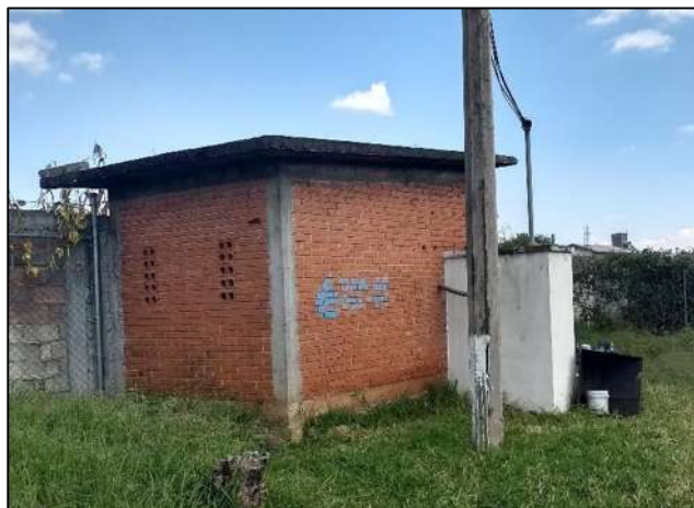
Figura 13. Pozo de extracción de agua subterránea “Los artesanos” (P1-A), que abastece a la comunidad de Capula.
