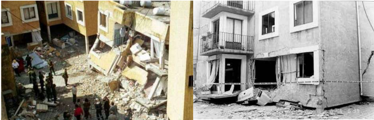
Figura 1.1. Colapso de dos edificios con planta baja débil en un condominio de la ciudad de Puebla a consecuencia del temblor del 15 de junio de 1999 (Fuente: El Sol de Puebla, 2023).
