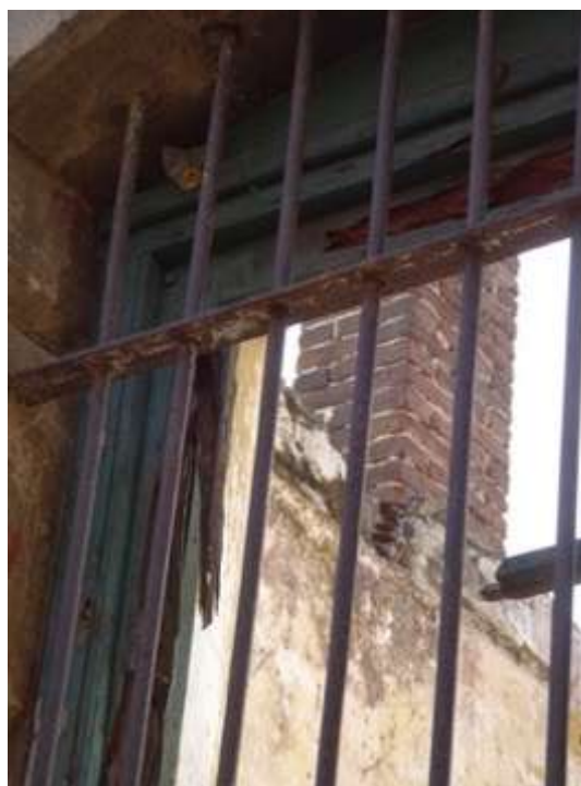
Figura 58: Herrería de ventana y marco original - Fotografía: David García Villegas , 2018
