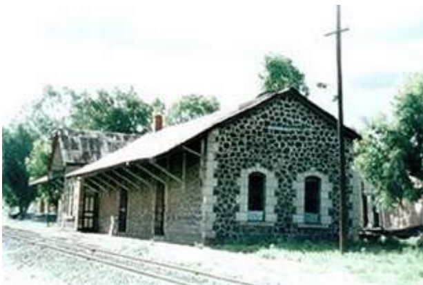
Figura 17: Estado anterior de la estación (año 1990 - 2000)
