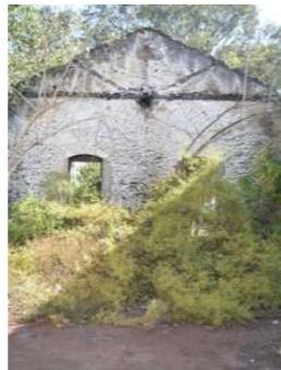
Fachada Oriente / Interior Fotografía David García Villegas Octubre 2017 Tiripetío Michoacán
