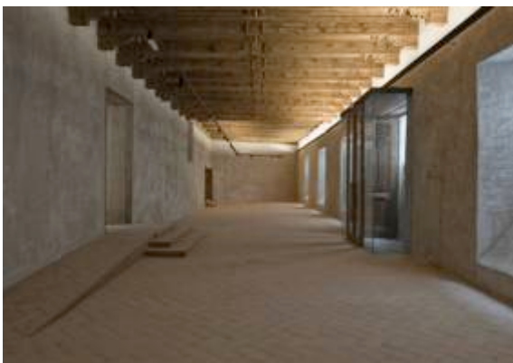
Figura 10 : Palacio condestable : https://www.metalocus.es/es/noticias/palacio-condestable-por-tabuena-leache-arquitectos : 2013
