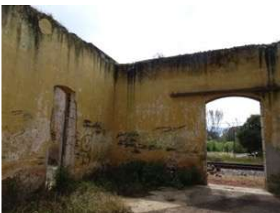
Figura 75: Interior de la estación de ferrocarril, Área de Bodega exprés.
