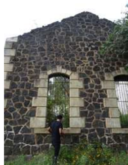
Fachada Oriente Fotografía David García Villegas Octubre 2017 Tiripetío Michoacán
