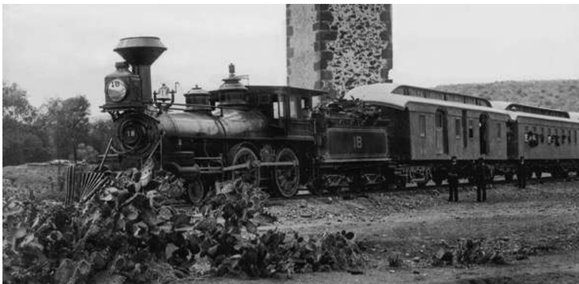
Figura 15: Maquina en tramo México Querétaro (Querétaro Michoacán)
