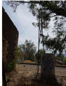
Fachada Poniente / vías Fotografía David García Villegas Noviembre 2017 Tiripetío Michoacán
