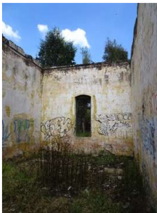
Figura 74: Interior de la estación de ferrocarril, área de oficina, muro norte y muro oriente.
