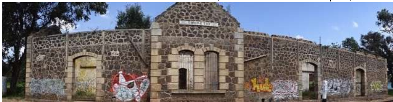
Figura 50: Estado Actual de la Estación: Bodega exprés, taquilla al centro y bodega a la derecha, Fotografía David Garcia Villegas
