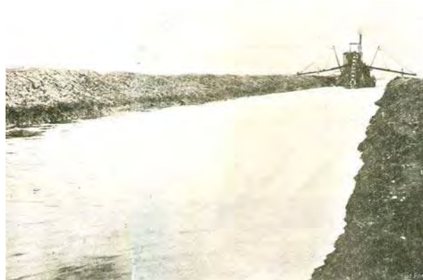
Imagen 1.- Draga americana realizando los primeros trabajos de desecación de la ciénega hacia 1897. Fuente:
