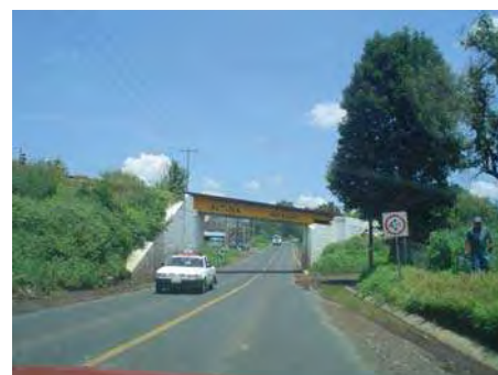
Imagen VII.- Camino real en Naranja; estado actual. Aportación del autor.
