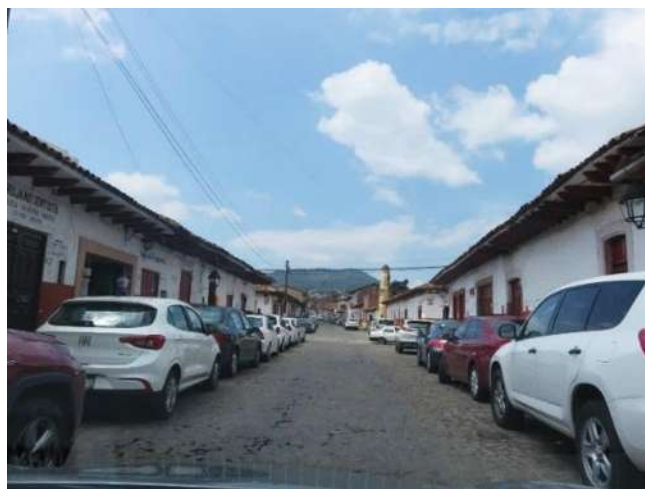
Imagen 8. Saturación de vehículos estacionados sobre vialidad, Pueblo Mágico Pátzcuaro, Michoacán. Fuente: fotografía de la autora, septiembre 2022.
