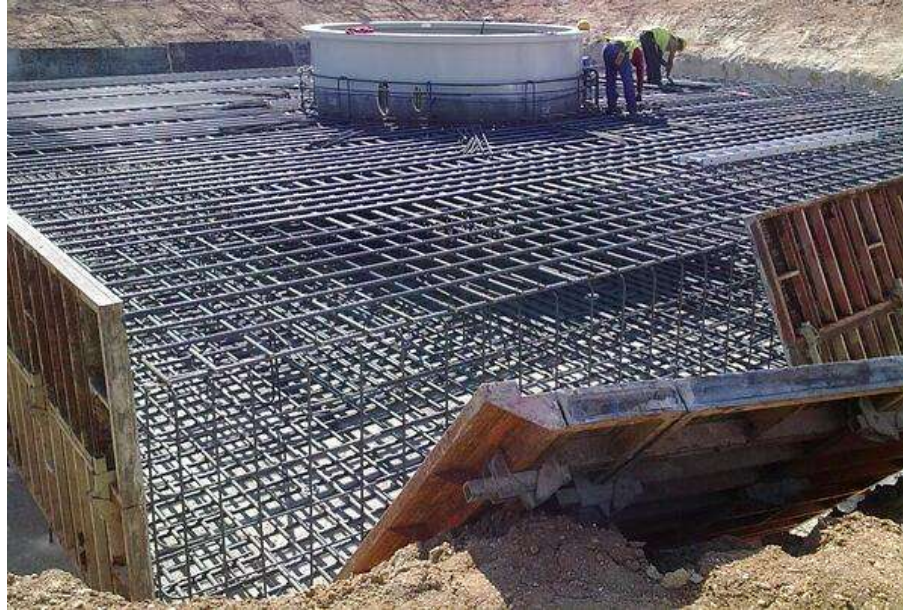
Figura 3.22 Imagen de referencia de la cimentación para un aerogenerador Vestas V27/225
