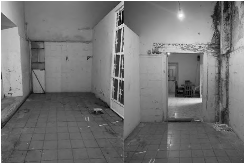
Ilustración 44 Fotografías del Baño Bodega. Fuente: Elaborada por autores.
