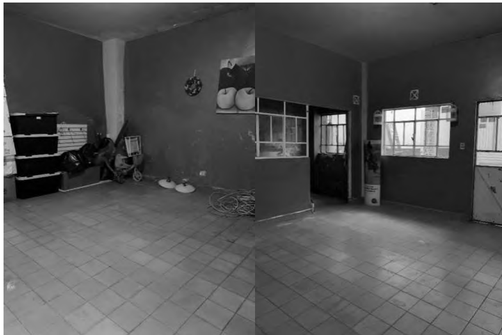
Ilustración 47 Fotografías del Baño Bodega. Fuente: Elaborada por autores.
