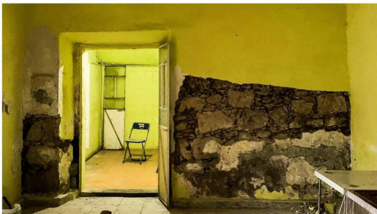
Composición de Apoyos corridos de mampostería irregular con núcleos de adobe dentro del edificio y cadenas de ángulo en cerramientos.
