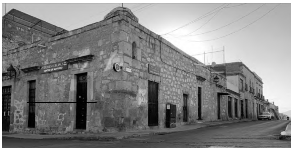
Ilustración 12 Fotografía tomada por autores.
