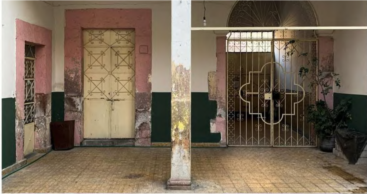
Elemento de Apoyo Aislado de piedra labrada ignimbrita con basamento y capitel dórico.
