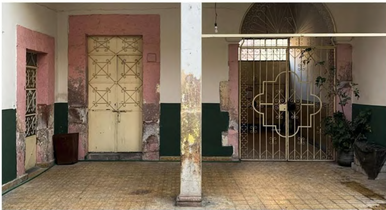
Elemento de Apoyo Aislado de piedra labrada ignimbrita con basamento y capitel dórico.
