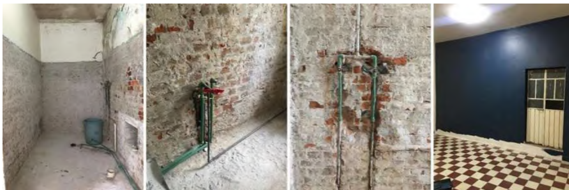
Ilustración 124 Fotografías de la remodelación. Tomadas por autores.
