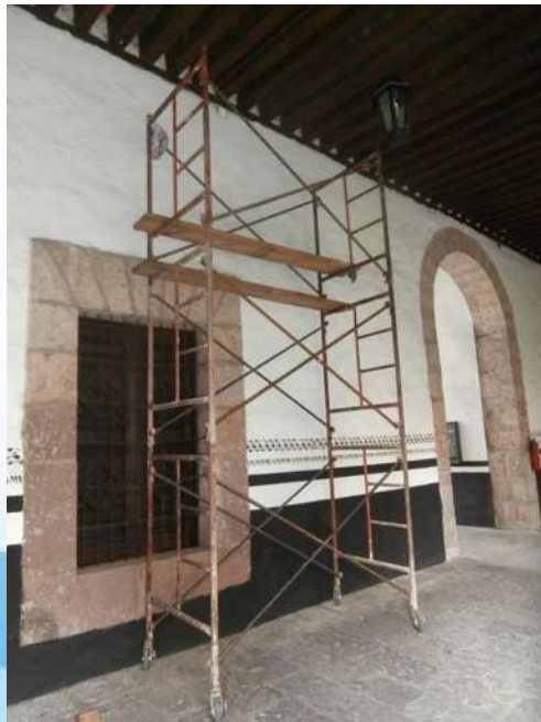
Figura 5. Andamios para diagnóstico
