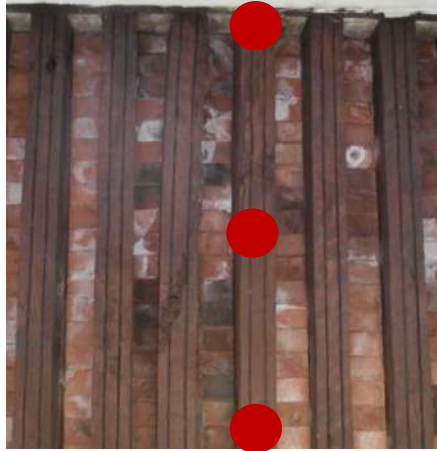
Figura 12. Puntos críticos de las Vigas
