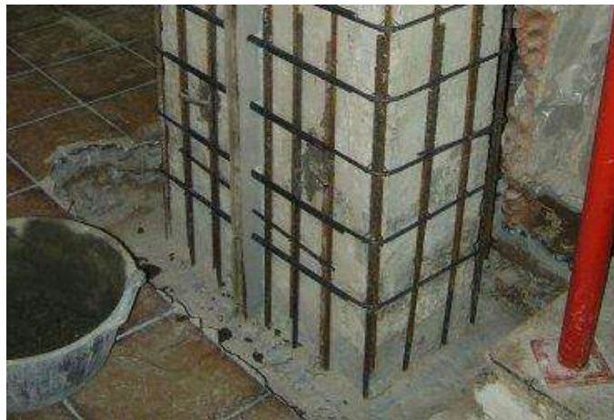
Figura 5.9. Preparación para encamisar con concreto una columna central de un edificio [25].
