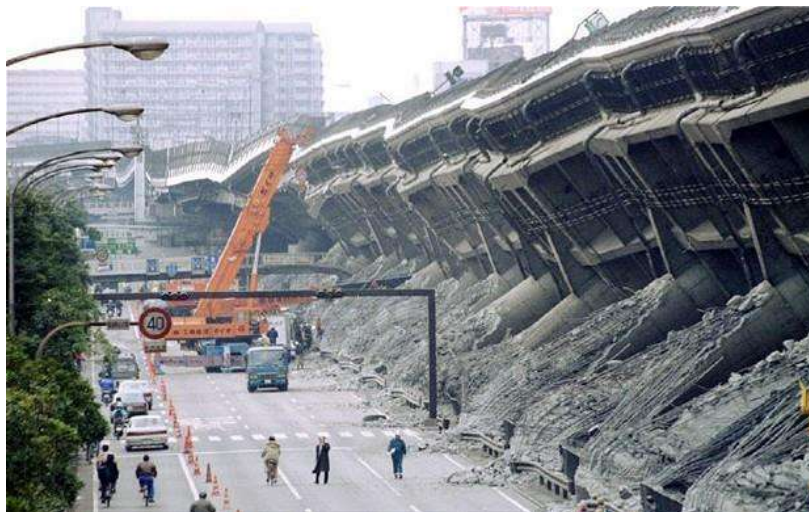
Figura 1.7. Colapso del viaducto "Hanshin Expressway" durante el sismo de Kobe en 1995 [1.7].
