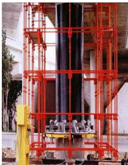
Figura 6.9. Encamisado de una columna con FRP utilizando una máquina automática [Chambi, 2010].
