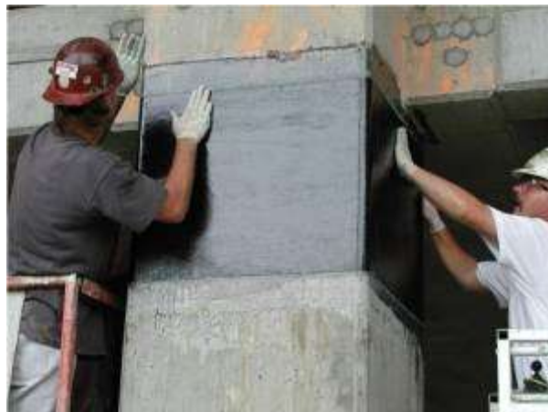
Figura 5.3. Refuerzo de una columna de un puente utilizando materiales compuestos [19].
