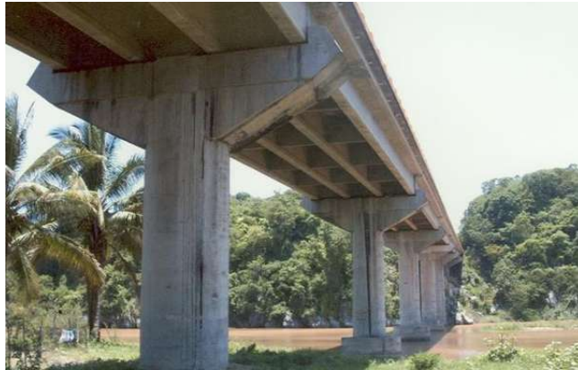
Figura 6.44. Vista general de la subestructura tipo del puente Nexpa.
