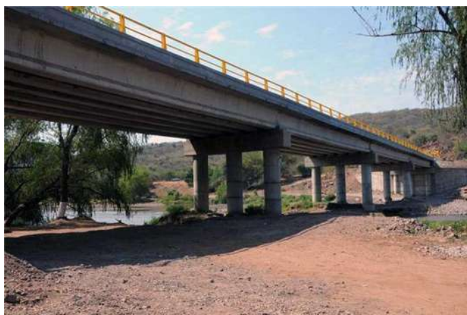
Figura 5.7. Puente El Carrizo – La Cofradía en Michoacán [23].
