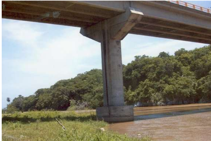
Figura 2.22. Vista lateral de una pila central sobre el cauce del río.
