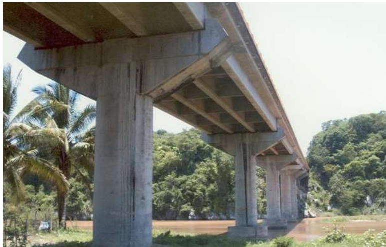
Figura 2.21. Vista general de la subestructura.
