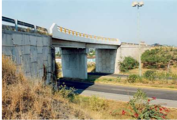
Figura 2.39. Vista general del puente en dirección a Manzanillo.
