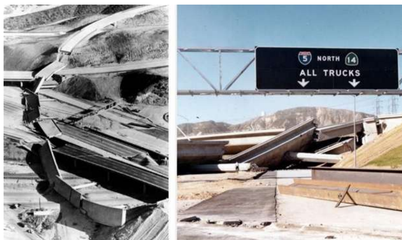
Figura 1.4. Puente colapsado durante el sismo de San Fernando en 1971 (Interestatal 5 – autopista 14) [1.4].
