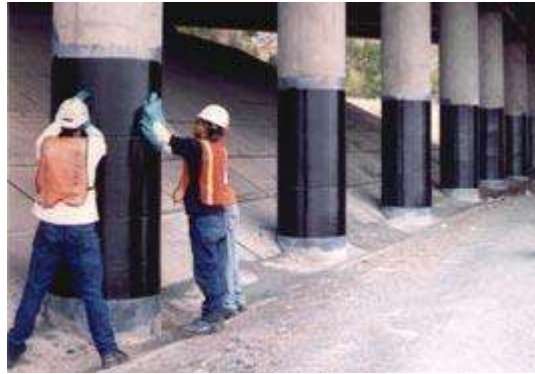
Figura 6.10. Columnas de un puente reforzadas con fibras de carbono [36].
