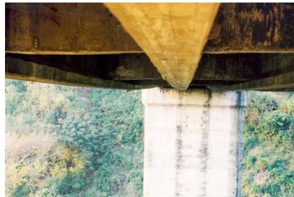
Figura 2.30. Vista inferior de uno de los claros con vista a la pila central.
