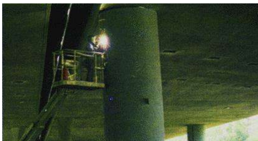
Figura 5.2. Colocación de camisa de acero a una columna de concreto [18].
