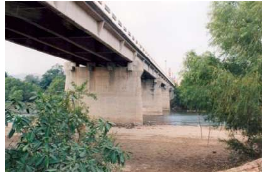
Figura 2.35. Vista general desde la margen izquierda de aguas arriba.
