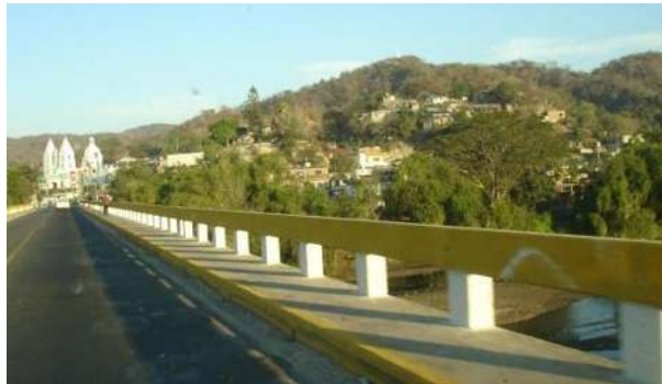
Figura 2.34. Puente Cihuatlán que pasa sobre el río del mismo nombre [2.34].
