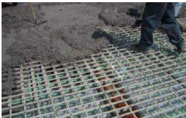
Figura 6.4. Colado de tablero de puente utilizando rejillas de fibra de vidrio como refuerzo [31].
