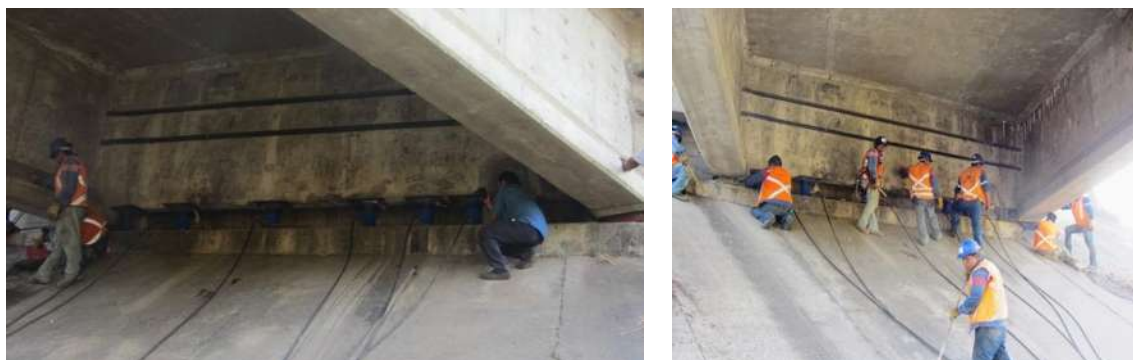
Figura 2.52. Trabajos de reparación de la superestructura del puente El Cuajilote empleando gatos hidráulicos por parte de la SCT [2.52].
