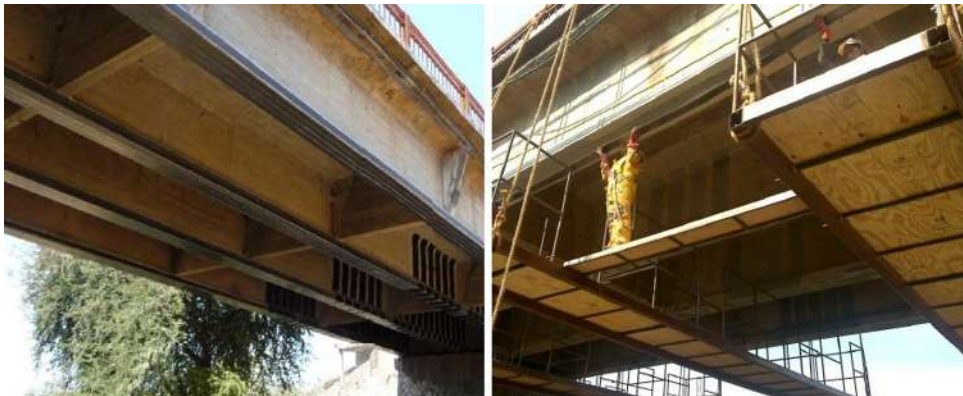
Figura 6.2. Refuerzo con FRP del puente Cutzamala [29].
