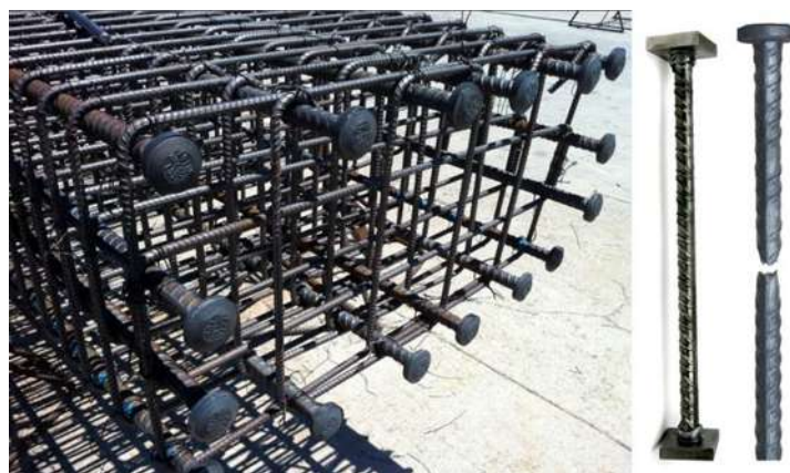
Figura 3.9. Armado de elementos de concreto con barras de doble cabeza [16].
