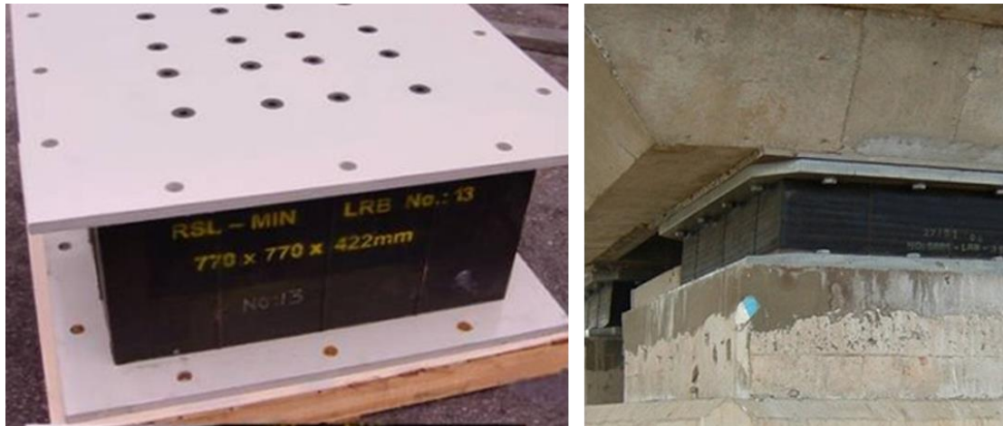
Figura 5.4. Apoyo de neopreno/plomo "Lead Rubber Bearing (LRB)" en pilas de un puente [20].
