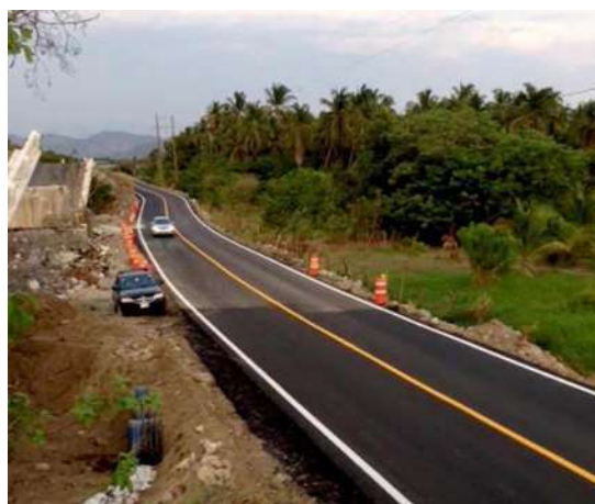
Figura 2.56. Paso provisional de dos carriles que mantiene la circulación de la carretera Acapulco-Zihuatanejo [2.56].
