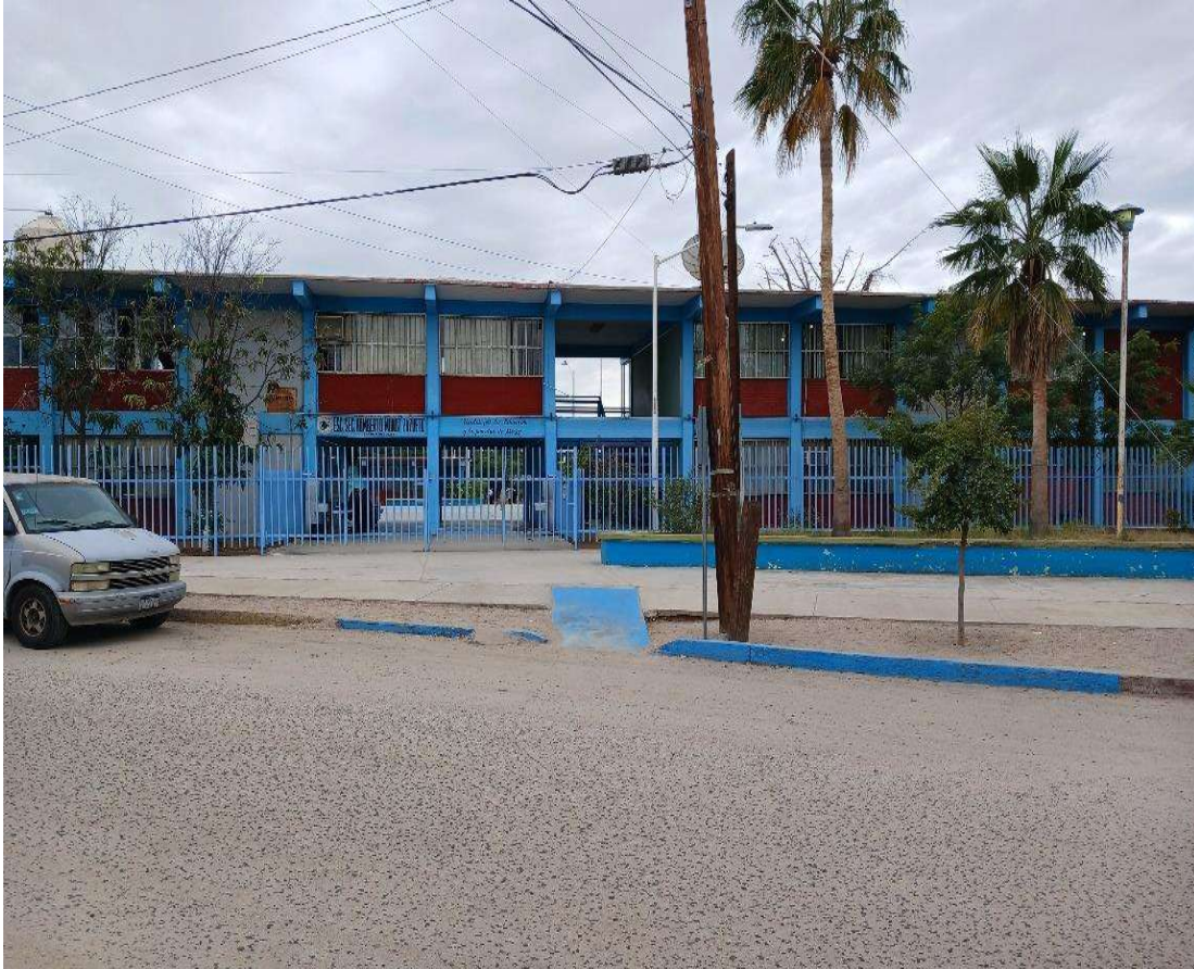
Imagen 6. Entrada principal de la escuela secundaria Humberto Muñoz Zazueta en La Paz Baja California Sur, esta se encuentra por la calle Urbano Angulo, se puede ver que cuenta con rampa de acceso para discapacitados y cerco perimetral.
