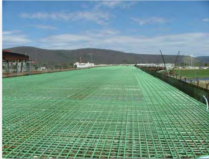
Figura 27. Aplicación de recubrimientos epóxicos en barras de acero de refuerzo
