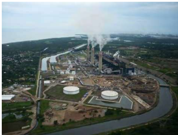
Figura 43. Central Termoeléctrica Plutarco Elías Calles.
