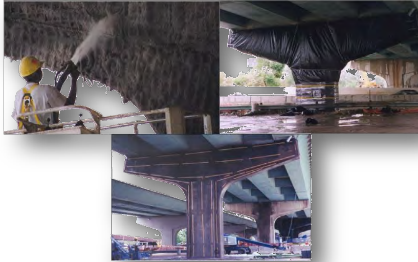
Figura 28. Extracción de los iones de cloruro que han penetrado el concreto.
