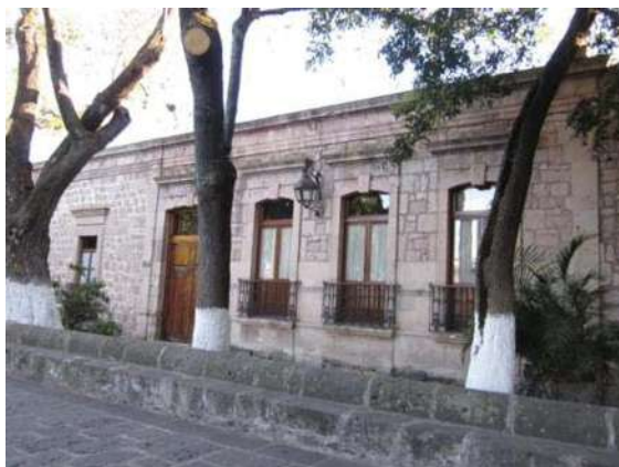
Imagen 60. Fachada de casa tipo alcayata, ubicada en la actual Calzada Fray Antonio San Miguel, Morelia. Michoacán.
