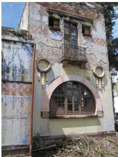
Imagen 45. Fachada de la casa del Arquitecto Adrián Giombini. Lote 13
