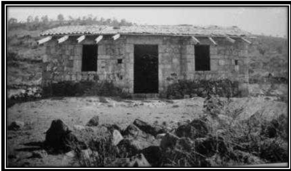
Imagen 2.3.- Cointzio, Municipio de Morelia, Edificio Escolar en construcción, AHSEP, Caja 14, Expediente 27, 1927.
