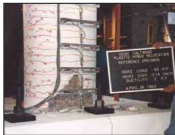
Figura 2. 7 Nivel de daño III (Hose et al. 1997)
