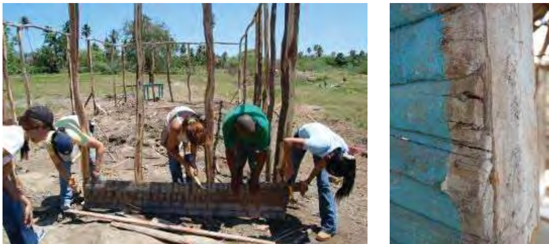
Figura 135. Clavado de las tablas de palma a los horcones y detalle del solape. Fotos: EPV
