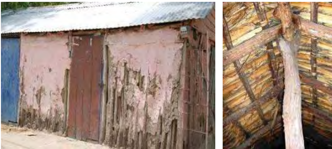
Figura 130. Pared de palos parados con restos de embarado y pie de amigo soportando la cumbrera de un bohío. Fotos: EPV
