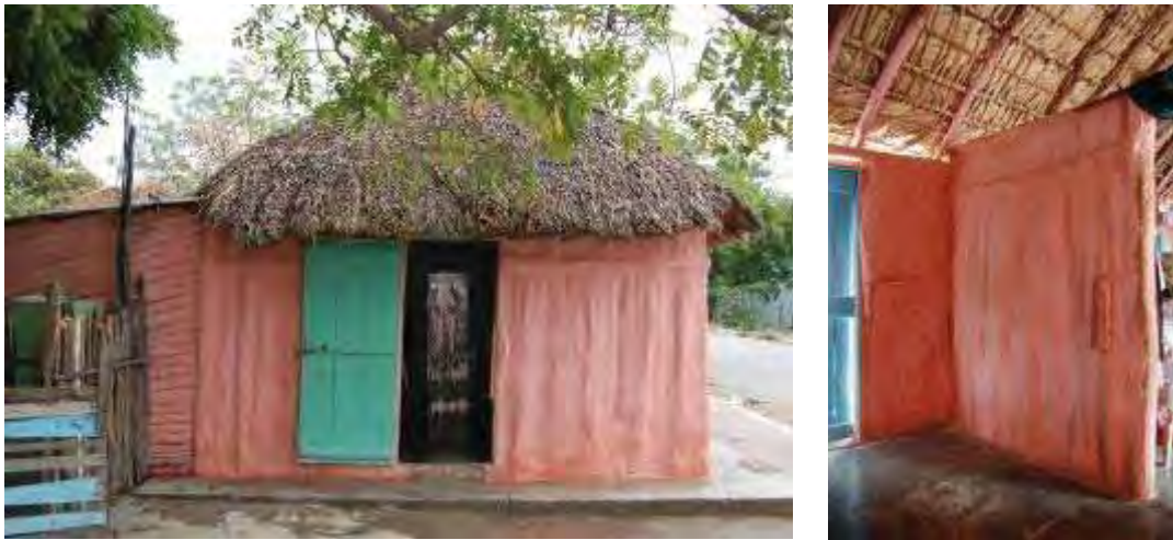
Figura 131. Exterior e interior de un bohío con paredes de palos parados, con embarrado y pintura a la cal con almagra. Fotos: EPV.
