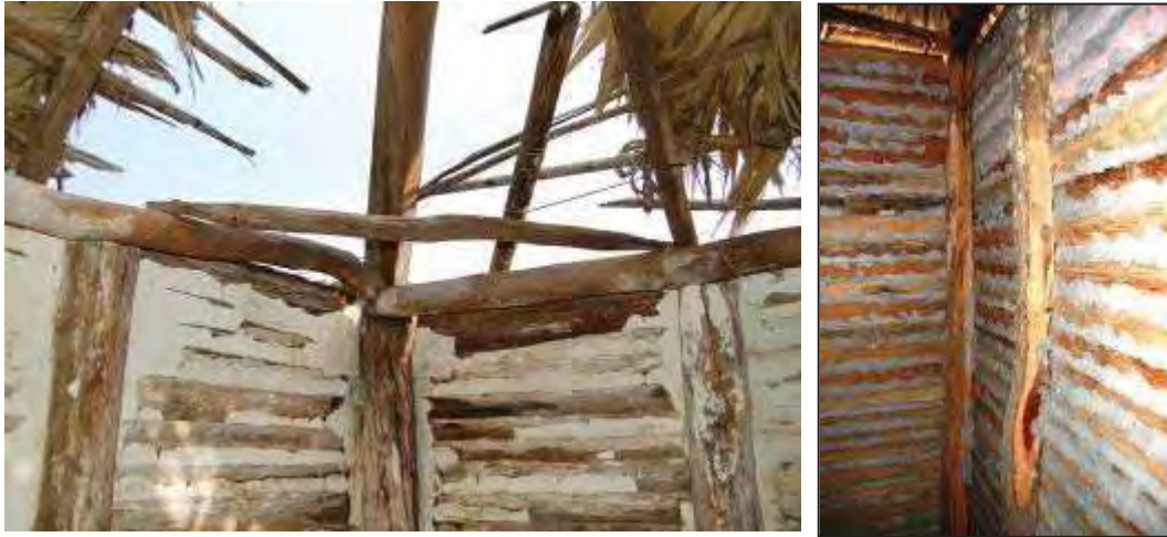
Figura 137. Resanes de las rendijas entre tablas de palma en el interior del bohío. a) con boñiga y ceniza; b) con mezcla de cemento. Fotos: EPV
