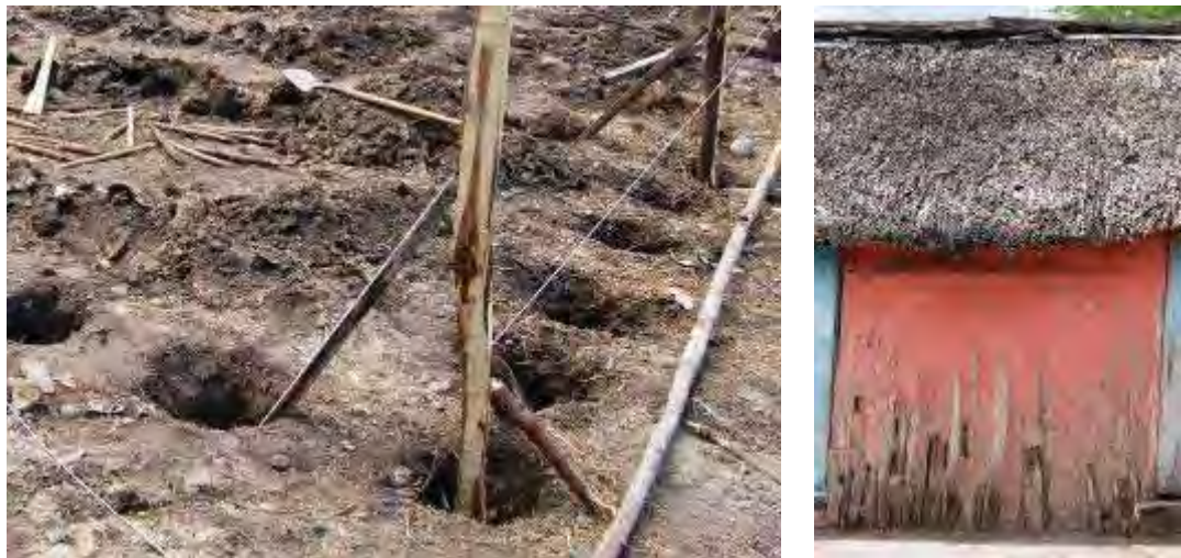
Figura 129. Proceso de hincado de los horcones o pies derechos y detalle de pared de palos parados. Fotos: EPV
