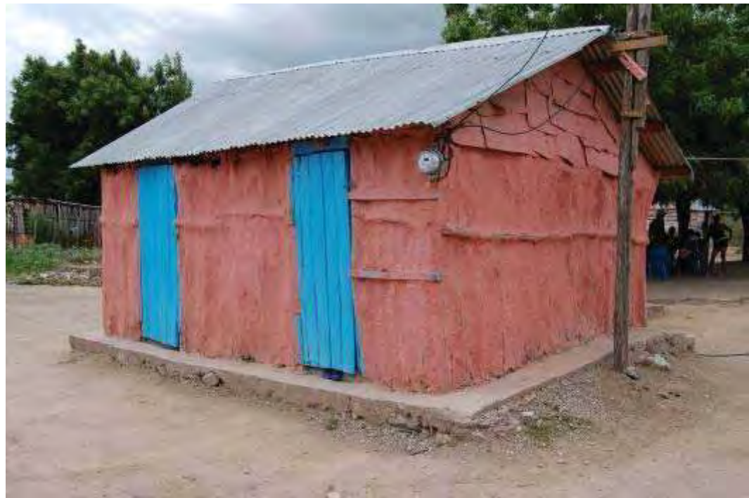
Figura 162. Bohío de palos parados con techo de láminas de zinc a dos aguas. Foto: EPV. 2008
