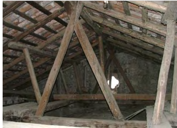
Figura 13C: San Francisco Ihuatzio. Cubierta de caballete, largueros, puntales y tijeras auxiliares. Fotografía: Armando Alexis Aguilar Ayala.
