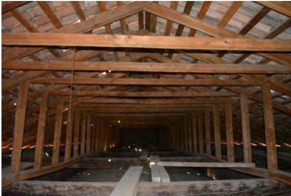
Figura 02C: San José Huecorio. Cubierta de pares y nudillos. Fotografía: Armando Alexis Aguilar Ayala.
