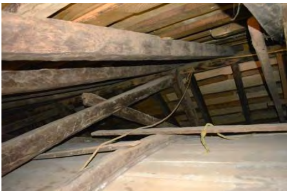
Figura 06C: San Francisco Uricho. Cubierta combinada entre caballete con pares y nudillos. Fotografía: Armando Alexis Aguilar Ayala.
