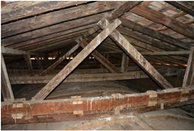
Figura 20: San Pedro Tzurumútaro. Cubierta de caballete, largueros, puntales y tijeras auxiliares. Fotografía: Armando Alexis Aguilar Ayala.
