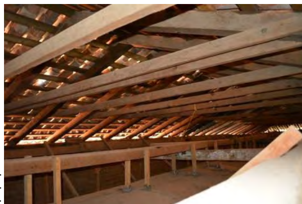
Figura 03C: San Pedro Pareo. Cubierta de pares y nudillos. Fotografía: Armando Alexis Aguilar Ayala.
