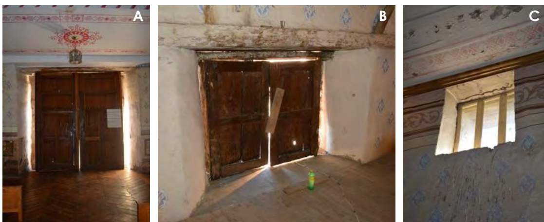
Figura 06: Santa María de la Natividad Arocutín. A) Puerta principal, B) Ventana de fachada, C) Ventana lateral. Fotografías: Armando Alexis Aguilar Ayala.
