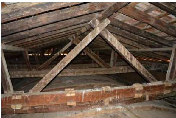
Figura 09C: San Pedro Tzurumútaró. Cubierta de caballete, largueros, puntales y tijeras auxiliares.
