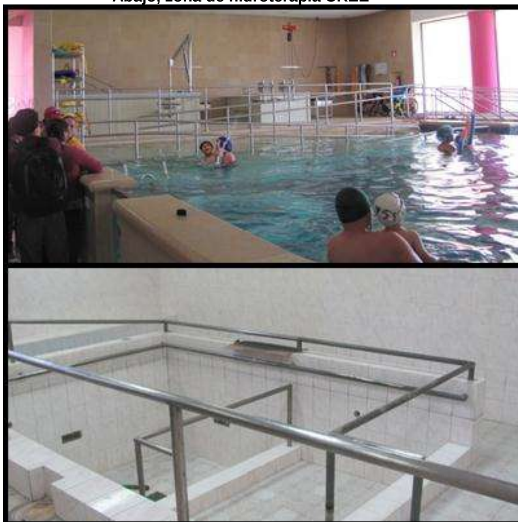
Imagen XVI. Arriba, zona de hidroterapia CRIT Abajo, zona de hidroterapia CREE
