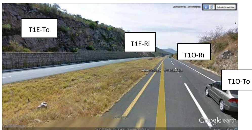
Figura 4.36.- Nomenclatura de los materiales del talud 1.
