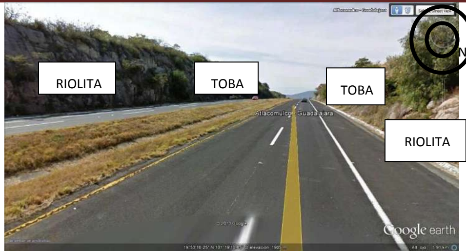
Figura 4.14.- Vista del talud 2, dirección México-Guadalajara (Google earth).
