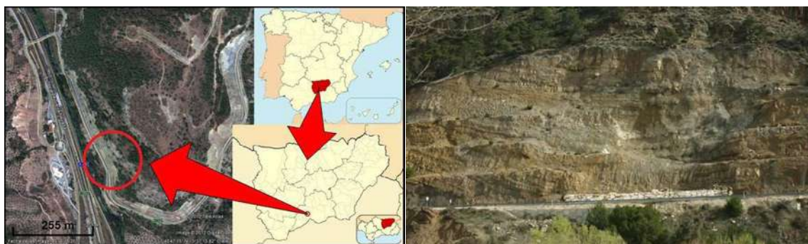
Figura 2.3.- En la imagen izquierda se muestra la localización del talud del tramo Izbor- Vélez de la Autopista Benaudalla y del lado derecho se muestra el corte del talud cubierto por malla metálica para retención de bloques y piedras.
