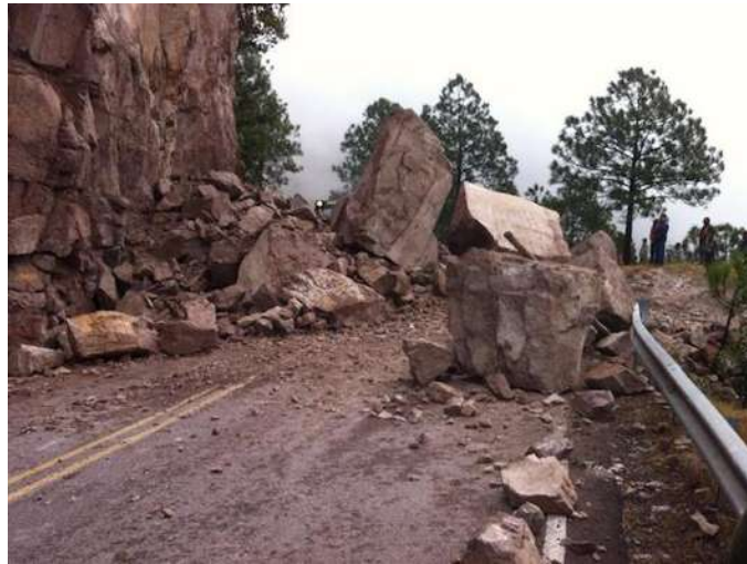
Figura 2.25.- Deslizamiento de un talud en la autopista Mazatlán-Durango debido a una falla geológica.
