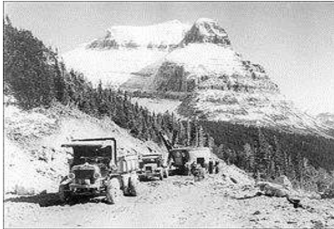
Figura 2.11.- Construcción de Vías de comunicación en la cadena montañosa de la Columbia Británica en Canadá.
