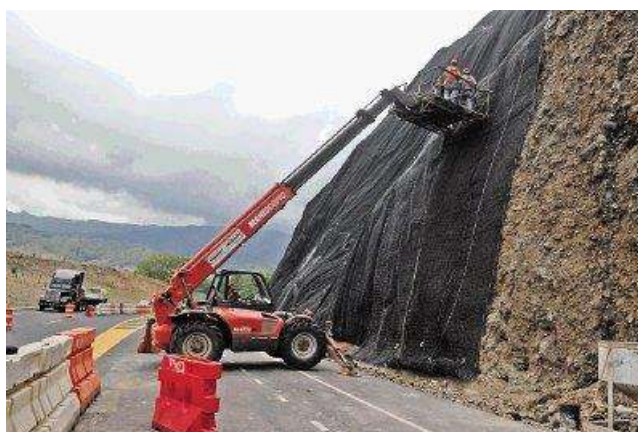
Figura 2.23.- Estabilización de un talud en la autopista del Sol con Malla de Triple Torsión y concreto Lanzado.
