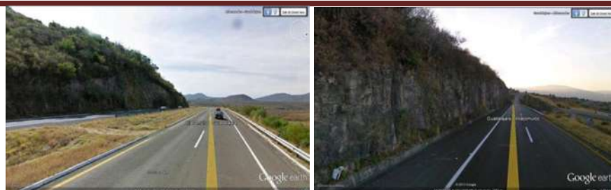
Figura 2.29.- En las imágenes se observan algunos taludes del tramo en estudio de la autopista México-Guadalajara (zona de estudio).
