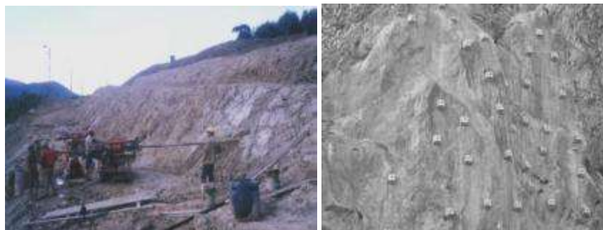
Figura 3.25.- Aplicación de carga de tensión de diseño al anclaje.
