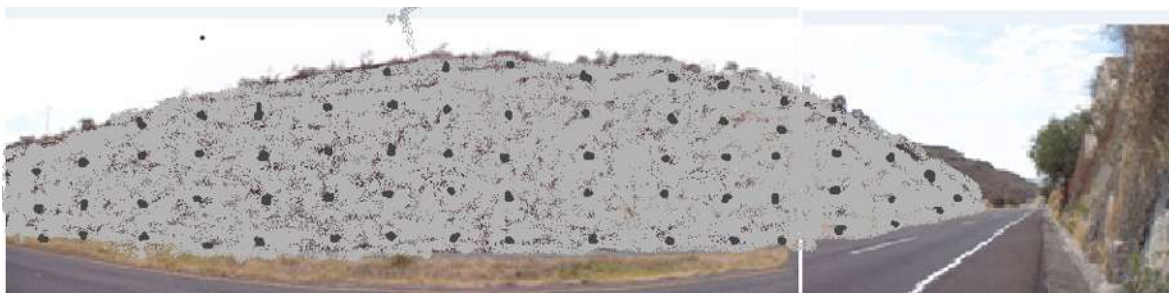
Figura 5.2. Vista preliminar del talud con concreto lanzado y anclajes activos para distribuir los esfuerzos (opción 2)
