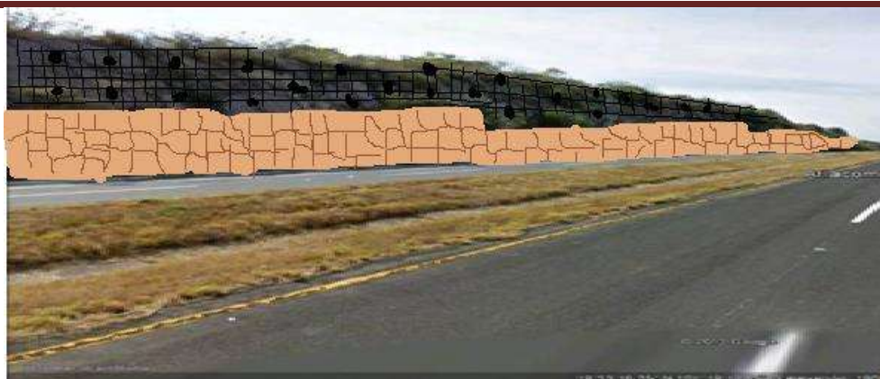
Figura 5.6. Muro de Gavión y malla Electro soldada con sistema de anclajes pasivos para distribuir las cargas.
