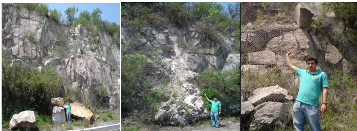
Figura 4.8.- Inspección preliminar para seleccionar los dos taludes en condiciones críticas.
