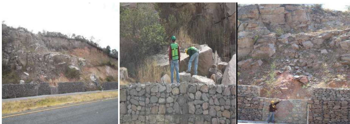
Figura 4.10.- Inspección preliminar en el talud para evaluar la situación actual del muro de gavión.
