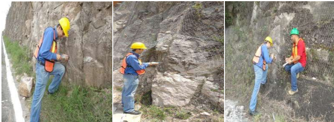
Figura 4.24.- Utilizando el esclerómetro en el talud 2, km 260+000 lado Norte.
