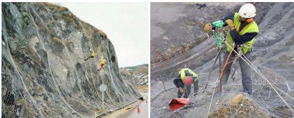
Figura 3.20.- Armado de Colocación de malla triple torsión con sus anclajes correspondientes.
