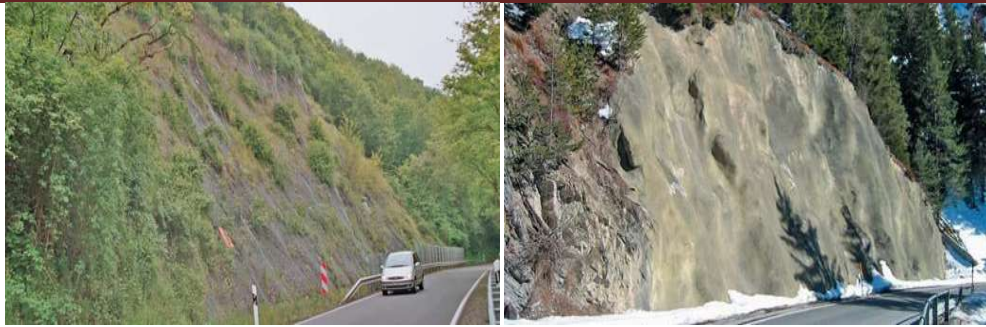
Figura 3.17.- En la imagen izquierda se muestra el talud cubierto con malla metálica y en la imagen derecha se muestra la malla recubierta con concreto y reforzada con anclajes.
