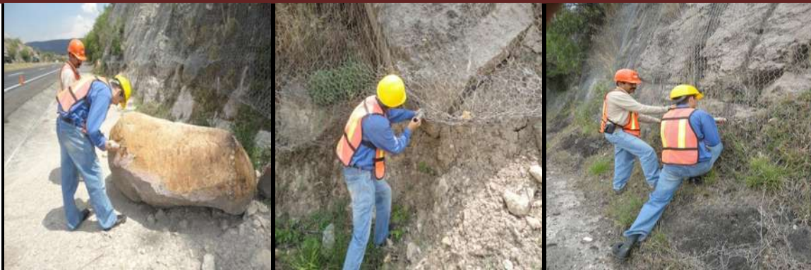
Figura 4.23.- Aplicación del esclerómetro en el talud 2, km 260+000 lado Sur, en Tobas y Riolítas.
