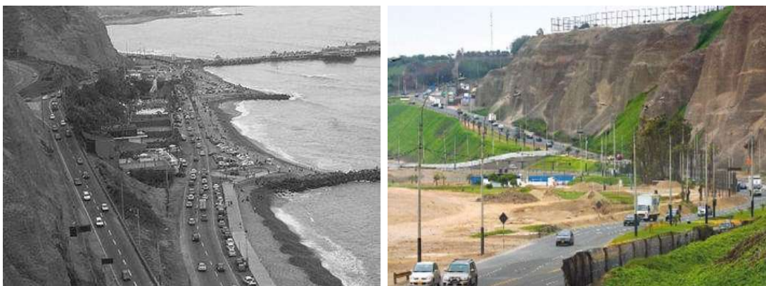
Figura 2.9.- Vialidad en Costa Verde, donde se observa en imagen izquierda la gran carga vehicular que se genera por la zona y en la imagen derecha el evidente peligro que corren los transportistas debido al gran talud de roca que se encuentra en la zona.
