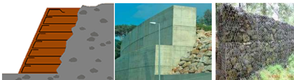
Figura 3.19.- Muros de contención de geomallas con suelo, concreto armado, y de mampostería.
