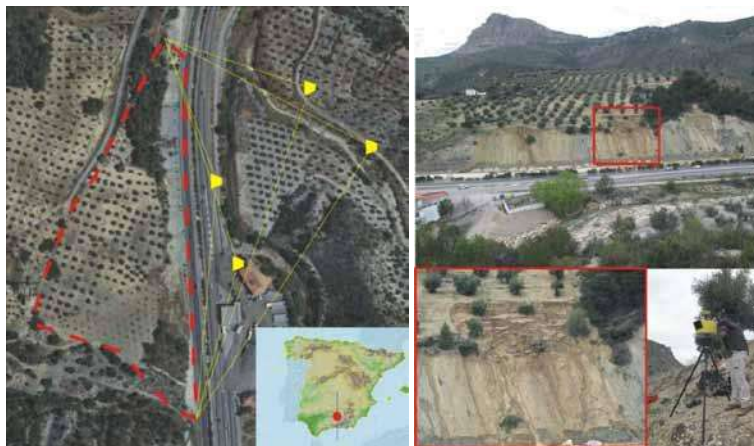
Figura 2.1.- En la imagen izquierda se muestra la Zona de estudio donde la línea roja discontinua marca la zona del deslizamiento y en amarillo se muestran las posiciones de las estaciones. Mientras que en la imagen derecha se muestran los taludes del estudio en corte.
