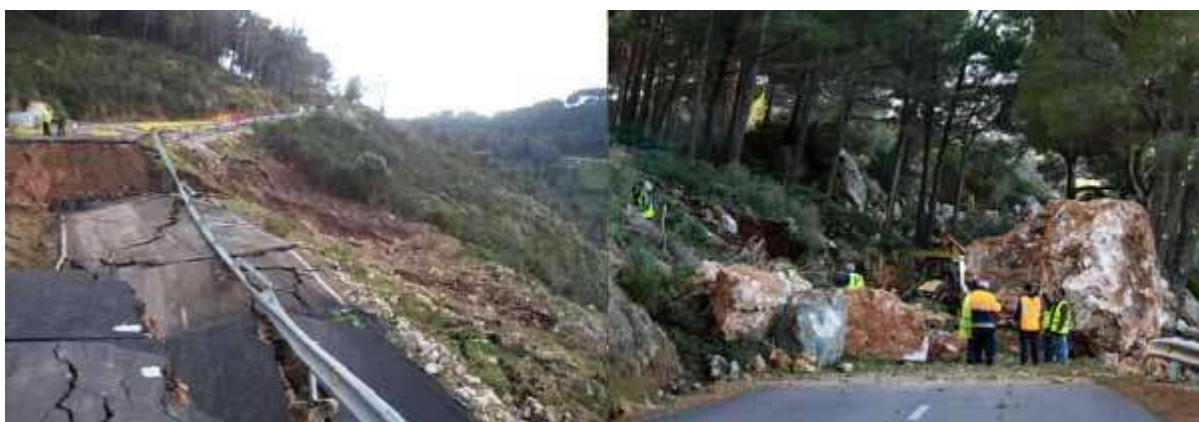
Figura 2.6.- Efecto de las 2 principales tipologías de inestabilidad de ladera en la Sierra de Tramuntana: Deslizamientos de suelos en Ma-10 km 105 (izquierda) y desprendimiento rocoso en Ma-10 Km 100 (Derecha).
