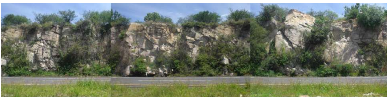
Figura 4.17.- Vista en corte del talud 2 Km 260+000, lado Norte.
