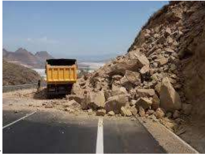
Figura 3.16. Desprendimientos en roca en autopista Mexicana.
