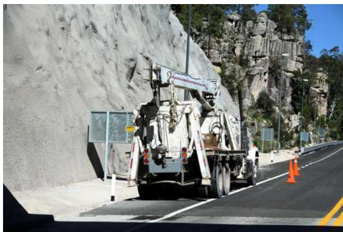
Figura 2.27.- Monitoreo constante de taludes inestables en la autopista Durango-Mazatlán.
