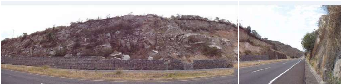
Figura 4.15.- Vista en corte del talud 1, en el Km 261+000, lado Este.
