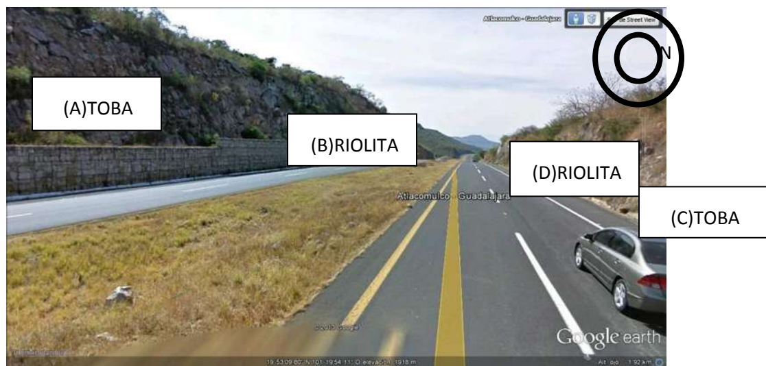
Figura 4.12.- Vista lateral del talud 1 (Google earth).
