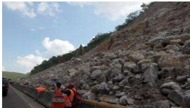
Figura 2.22.- Problemas de movimientos de roca en la autopista del Sol en el tramo Cuernavaca-Acapulco.
