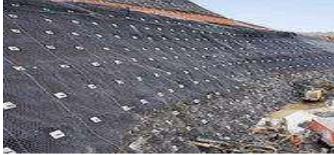
Figura 3.27.- Red metálica y anclajes de anclajes para distribuir las cargas.
