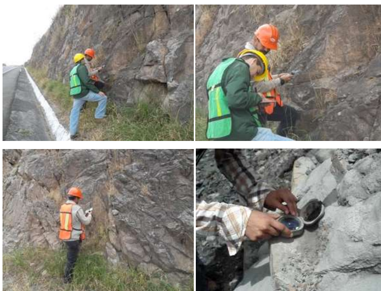
Figura 4.28.- Lecturas talud 1 con la brújula bronton directamente sobre la roca.
