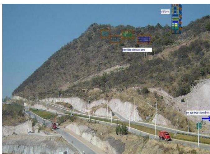
Figura 2.18.- Taludes en la Vialidad de Acceso a ciudad Tres Marías, en Morelia, Michoacán.
