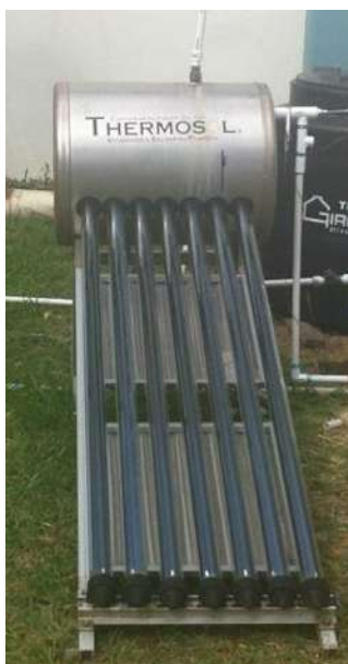
Figura 3.4. Calentador solar de tubos evacuados
