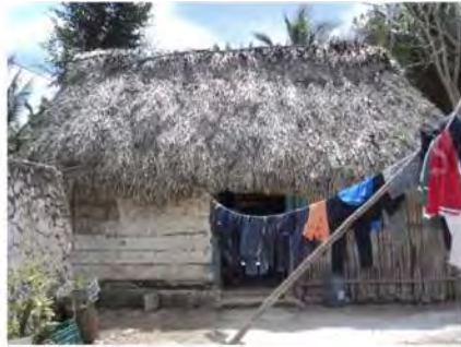
Muros de bajareque
