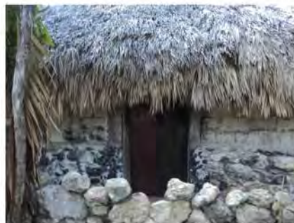
Muros combinados: base de piedra y parte superior bloques de concreto
