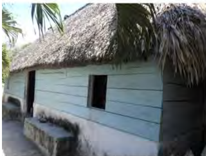
Muros combinados: base de piedra y parte superior de tablones de madera
