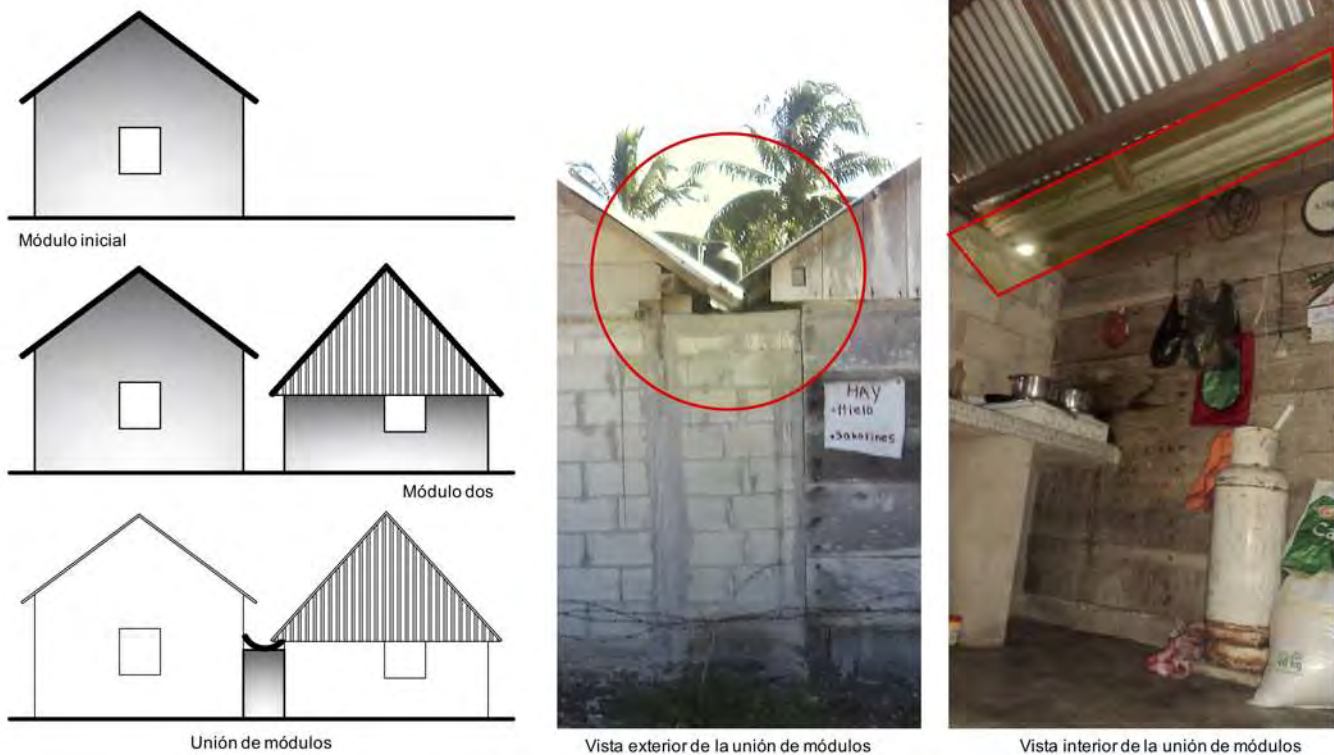
Figura 3.8. Canaleta para desalojo de aguas pluviales
