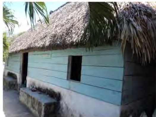
Núcleo con muros de base de piedra y parte superior de tablones de madera. Techo de huano. Presidente Juárez, Quintana Roo.
