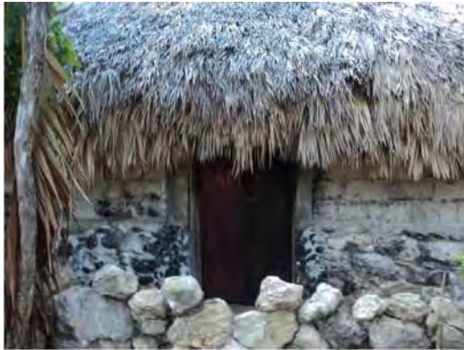
Núcleo con muros de base de piedra y parte superior de bloques prefabricados. Techo de huano. Chacchoben, Quintana Roo.
