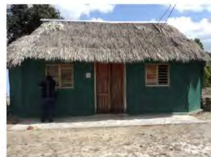
Muros de bloques de concreto
