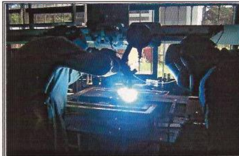
EJECUCION DE LA UNION MEDIANTE GMAW
