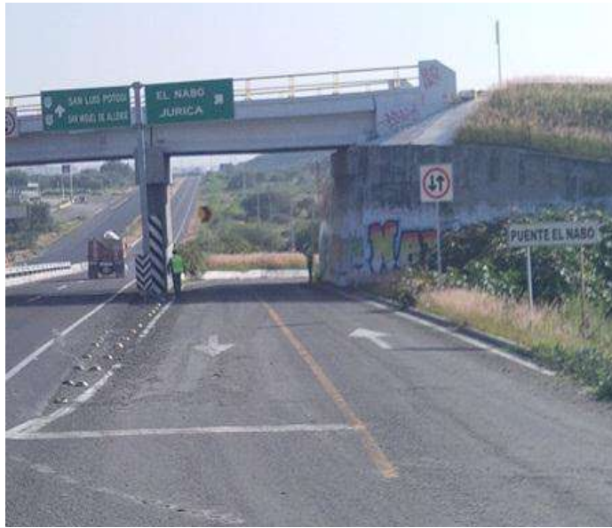
Figura 19. Apoyo de la estructura (View Street)
