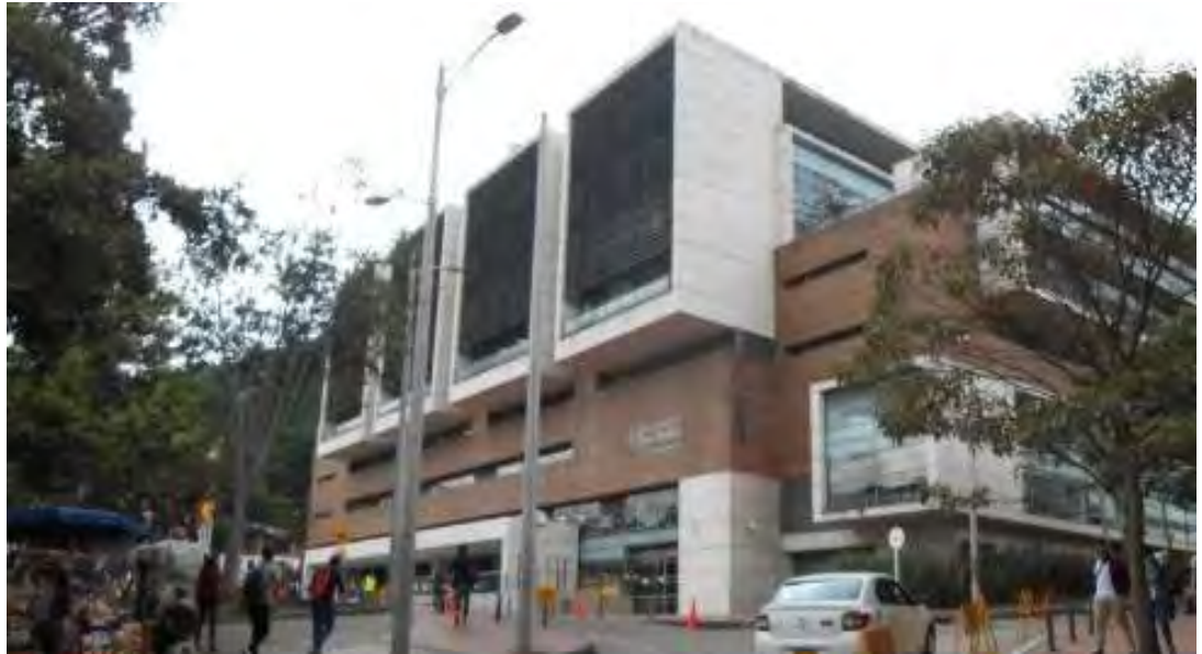
Figura 120. Fachada principal. Foto: Paula Ordóñez.
