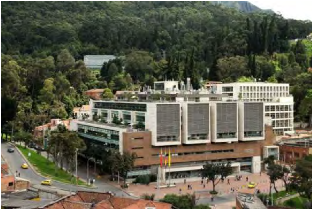
Figura 168. Edificio Mario Laserna y Centro Deportivo, proyectos de conjunción y disyunción en la Universidad de los Andes. Fuente: www.culturacolectivoa.com
