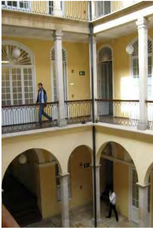
Figura 69. Lenguaje Interior del edificio patrimonial. Fuente: Tectus Ltda.
