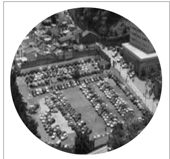
Figura 115. Consolidación del parqueadero. Fuente: Bermúdez & Valenzuela.
