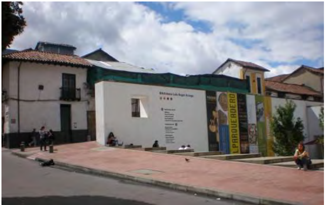
Figura 86. Muro Carrera 4. Foto: W. Pasuy A.
