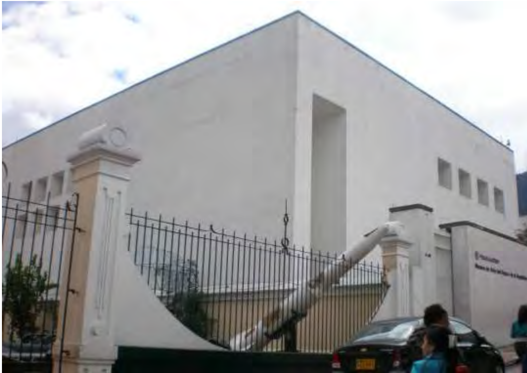
Figura 91. Morfología arquitectónica de la fachada sobre la calle 10. Fuente: el Autor. 2014.
