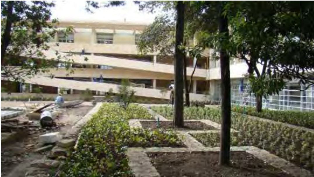
Figura 65 y 66. Vista interior – patio central. Fuente: Tectus Ltda.
