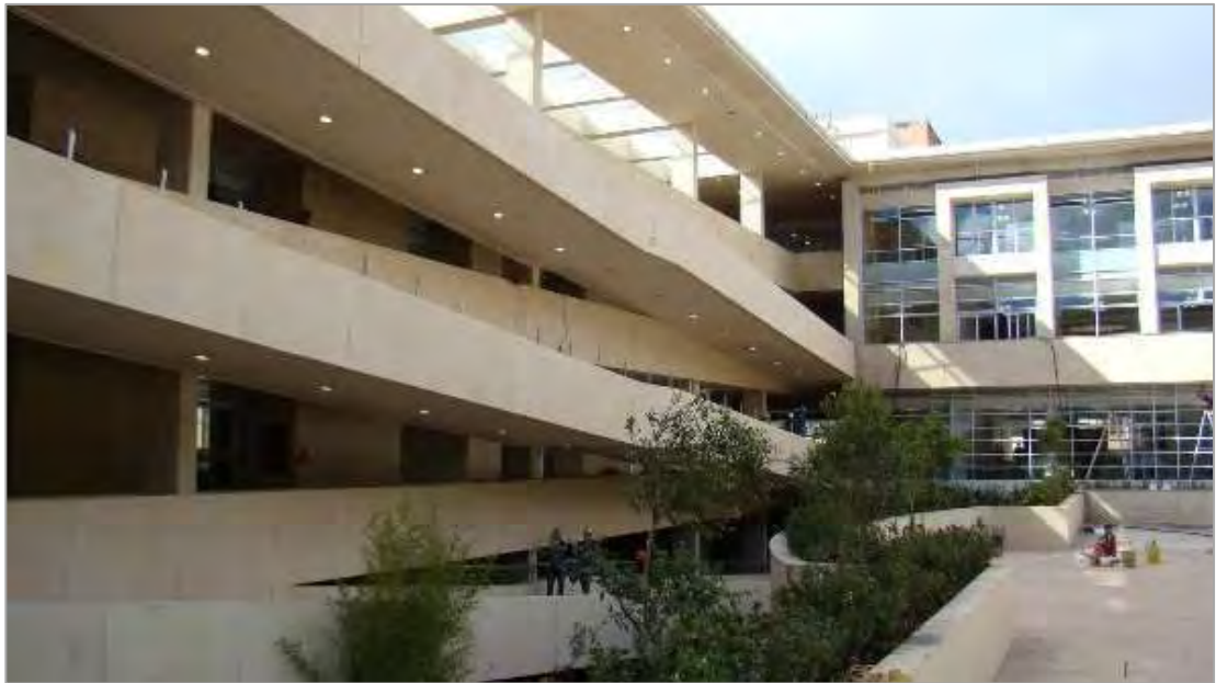
Figura 67. Carácter interior – patio central. Fuente: Tectus Ltda.
