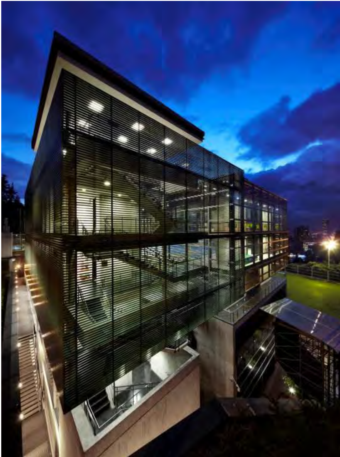
Figura 142. Imagen general del proyecto. Foto: Juan Silva . http://www.archdaily.co/co/610294/polideportivo-universidad-de-los-andes-mgp-arquitectura-y-urbanismo-felipe-gonzalez-pacheco
