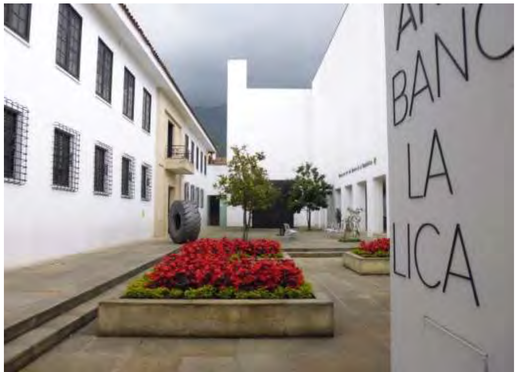
Figura 107. Estrategia de articulación volumétrica: el patio central. Fuente: https://christopherburkecolombia.files.wordpress.com/2014/01/banco.jpg
