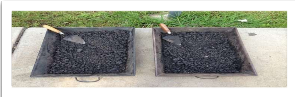
Imagen 4.10: Mezcla asfáltica lista para compactar
