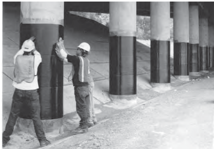
Figura 2.8 Encamisado de columnas en un puente con FRP
