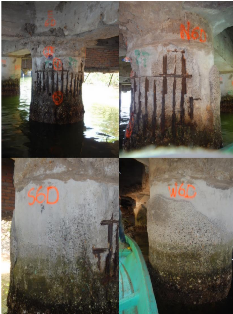
Fig. 82. Granos Pila E6D, reportada con nivel de daño 6 PF 3-4CCPa (tres o cuatro caras dañadas con pérdida de acero).
