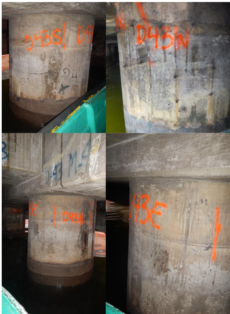
Fig. 72. BC pila D43N M14, reportada con nivel de daño 6 PF 3-4CCPa (tres o cuatro caras con pérdida de acero).
