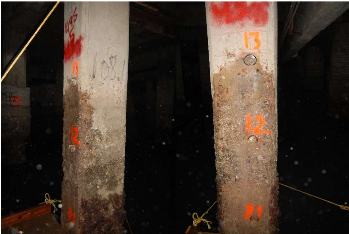
Fig. 46. Pilote 49S5, reportado sin daño.
