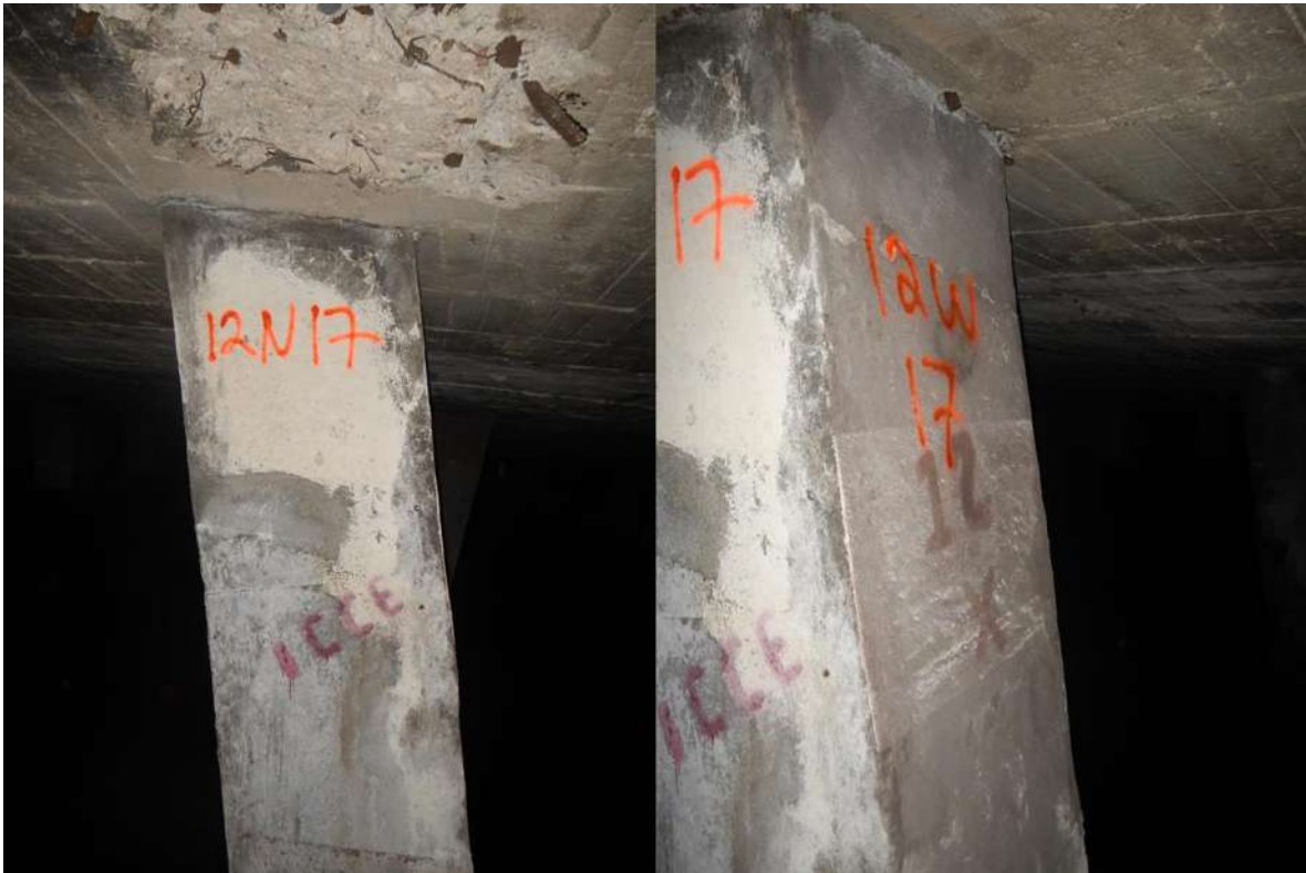
Fig. 66. BC pilote 12W17 XVII, reportada con nivel de daño 2 PB 2CSPa (dos caras dañadas sin pérdida de acero).
