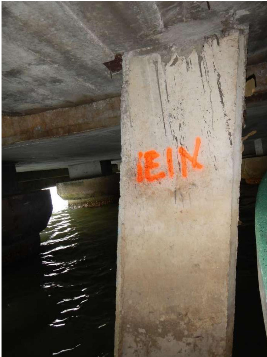
Fig. 49. Pilote 1E1E M10, reportado con nivel de daño PD 1CCPa (una cara dañada con pérdida de acero).
