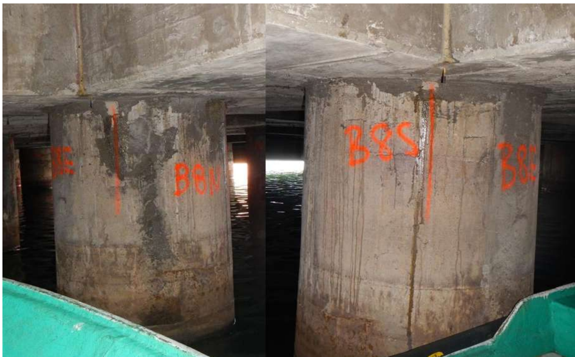
Fig. 62. BC pila B8N M14, reportada con nivel de daño 2 PB 2CSPa (dos caras dañadas sin pérdida de acero).
