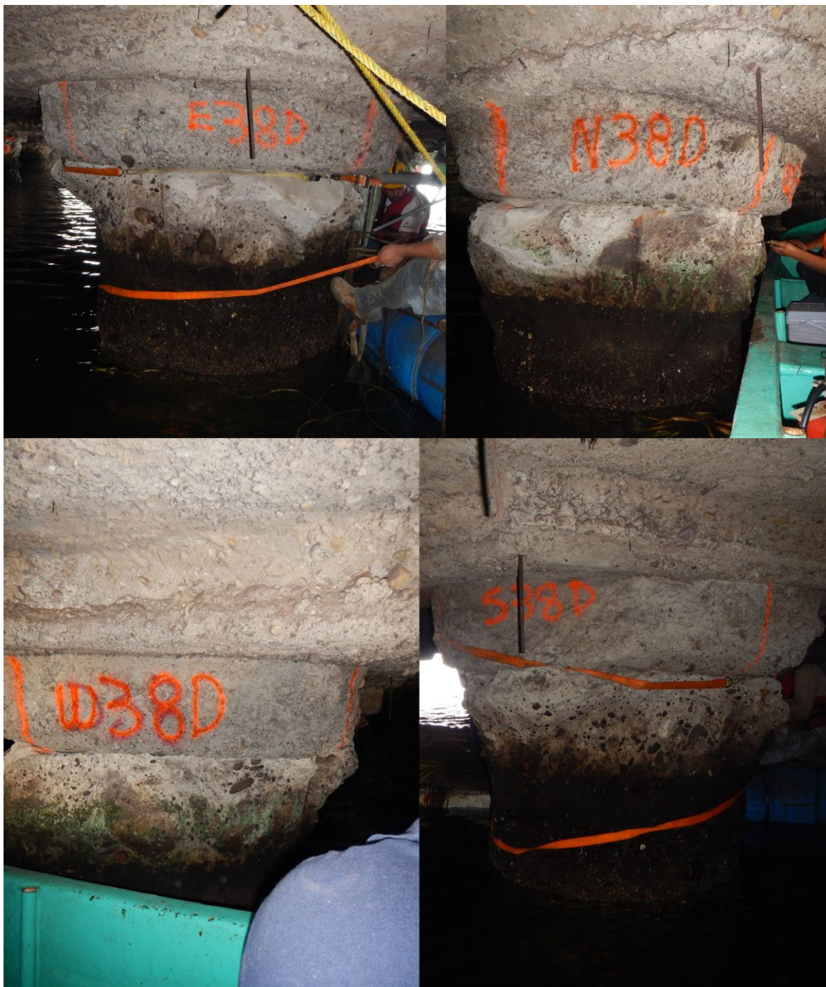
Fig. 74. M2 Pila N38D, reportada sin daño.
