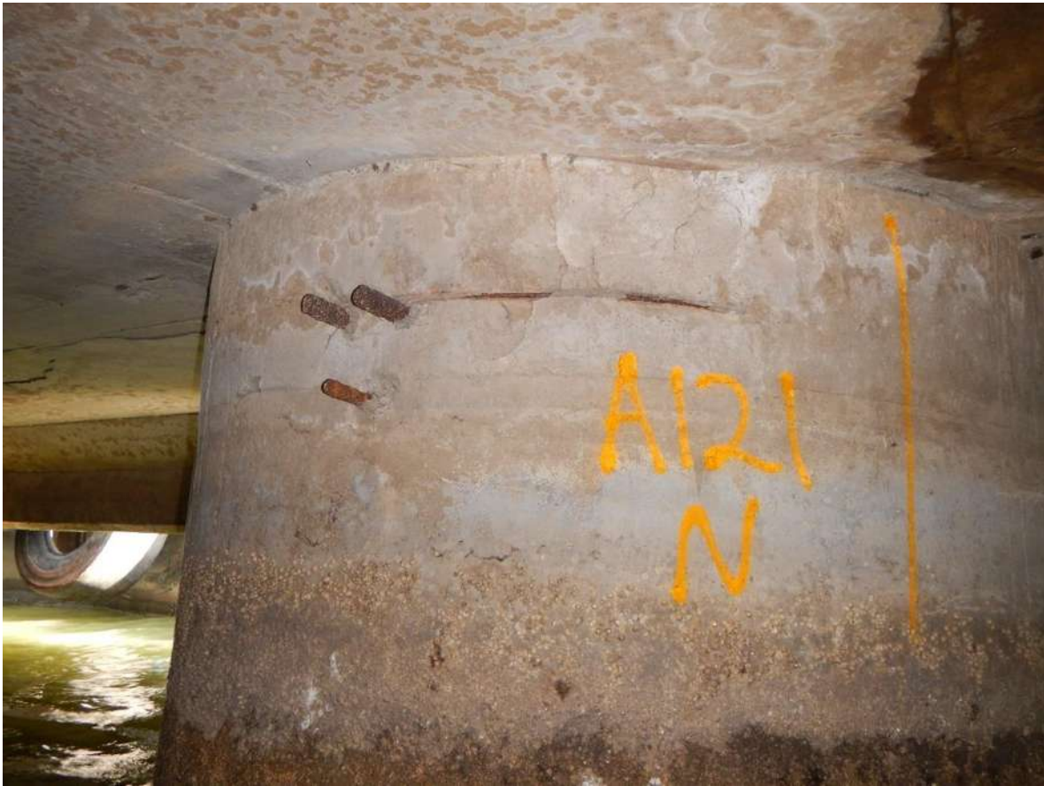
Fig. 56. Pila A121E M6, reportada con un nivel de daño 4 PD 1CCPa (una cara dañada con pérdida de acero).
