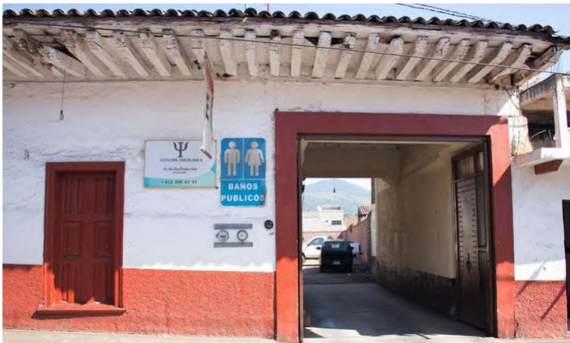
Figura 3.38. Irregularidad en altura de la vivienda AR29 por cambio de uso a estacionamiento. Fotografía: (A. Solís-Sánchez, 2021).
