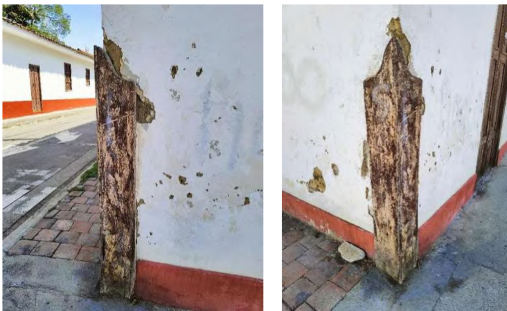
Figura 1.20. Refuerzo de madera en esquina de una vivienda de adobe en Buga, Valle del Cauca, Colombia. Fotografía: (A. Sánchez-Calvillo, 2021).
