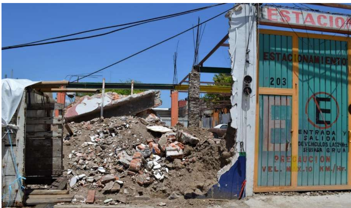
Figura 1.26. Colapso total de vivienda de adobe en Jojutla. Fotografía: (E. G. Navarro-Mendoza; A. Sánchez-Calvillo, 2018).
