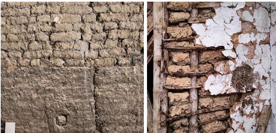
Figura 2.28. La fotografía para el estudio de la técnica constructiva: (a) Muro combinado de tapia y adobe en Buga, Valle del Cauca, Colombia; (b) Sistema constructivo de bahareque en El Cairo, Valle del Cauca, Colombia. Fotografías: (A. Sánchez-Calvillo, 2021).
