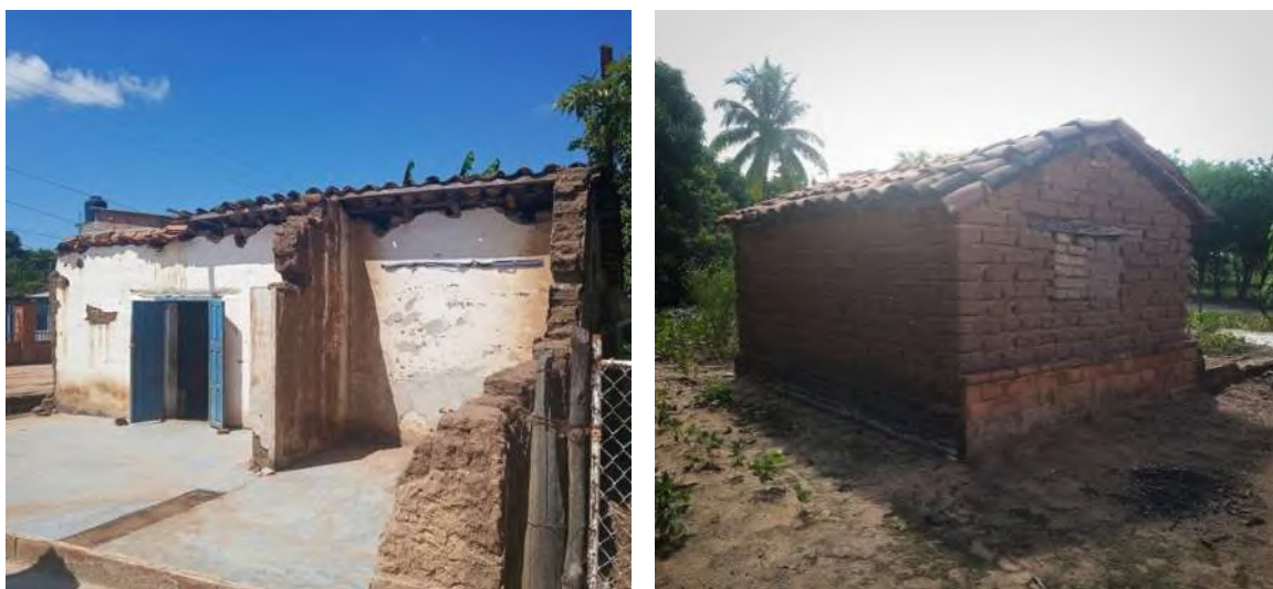
Figura 1.19. Viviendas de adobe y su distinta respuesta sísmica en Jiquipilas, Chiapas, México. Fotografías: (A. Sánchez-Calvillo, 2019).
