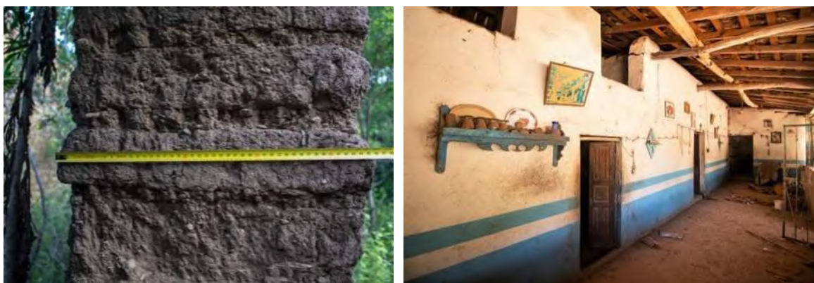
Figura 3.9. Relación de esbeltez en los casos de estudio: (a) Medición del grosor de muro en SPE; (b) Visualización de la esbeltez en muros de vivienda en SC. Fotografías: (I. Velasco-Hernández, K. L. Salvador-Alcalá, 2020; A. Solís-Sánchez, 2021).
