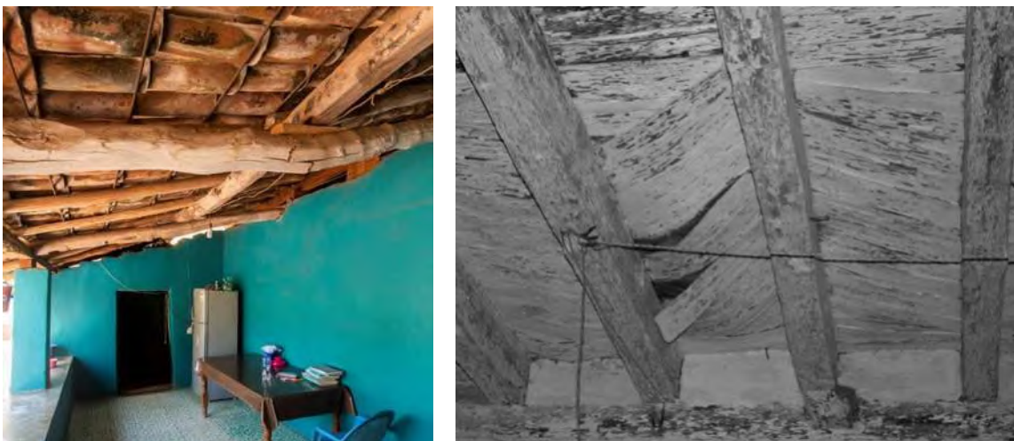
Figura 3.21. Sistemas de diafragma en viviendas de adobe: (a) Sistema con vigería simple de madera apoyada sobre los muros en vivienda de Santa Cruz de Morelos, Michoacán, México; (b) Sistema de vigería encastada en los muros y tablones de madera en vivienda de Ario de Rosales, Michoacán, México. Fotografías: (A. Solís-Sánchez, 2021).
