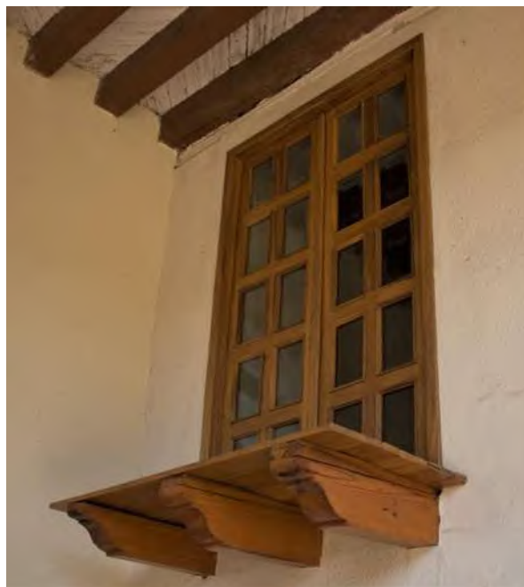
Figura 3.43. Alteración de los sistemas tradicionales y las fachadas mediante cornisas y ménsulas en aberturas de viviendas de AR. Fotografías: (A. Solís-Sánchez, 2021).
