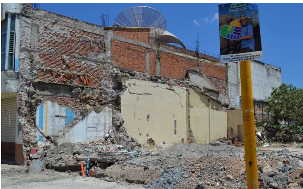
Figura 2.47. Demolición en predio. Fotografía: (A. Sánchez-Calvillo y E. G. Navarro-Mendoza, 2018).
