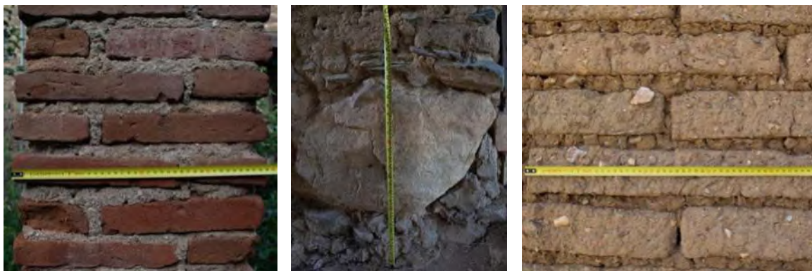
Figura 2.52. Elementos constructivos en las viviendas de adobe de San Pablo Etla, Oaxaca, México: (a) Columnas de ladrillo cerámico en pórtico; (b) Sistema de cimentación de mampostería irregular; (b) Mampostería de adobe rejuntada con mortero de barro. Fotografías: (I. Velasco-Hernández y K. L. Salvador-Alcalá, 2020).
