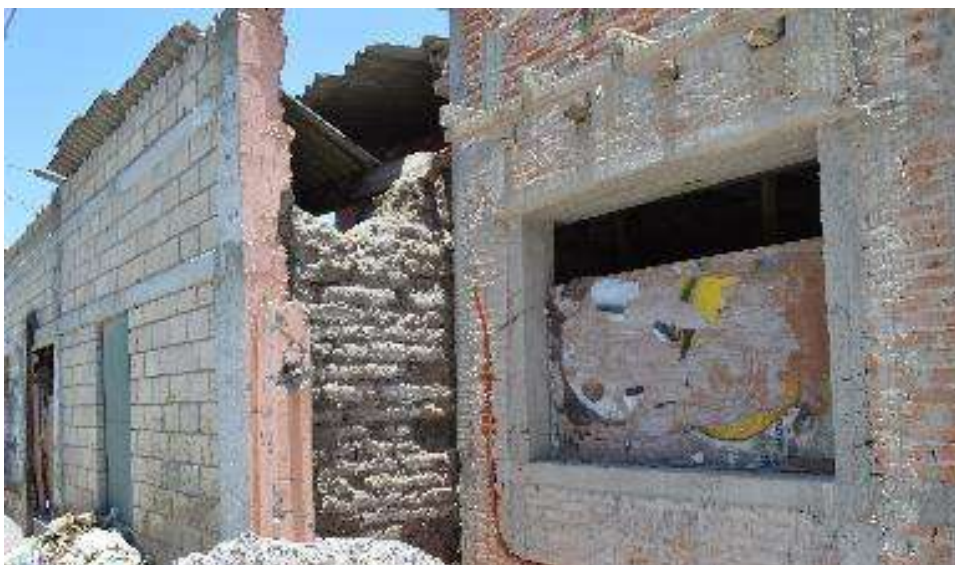
Figura 2.43. Vivienda severamente dañada tras el sismo con claras modificaciones al sistema constructivo original. Fotografía: (A. Sánchez-Calvillo y E. G. Navarro-Mendoza, 2018).
