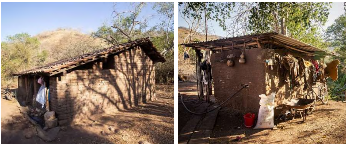
Figura 2.67. Tipologías constructivas en Santa Cruz de Morelos, Michoacán, México. Fotografías: (A. Solís-Sánchez, 2021).
