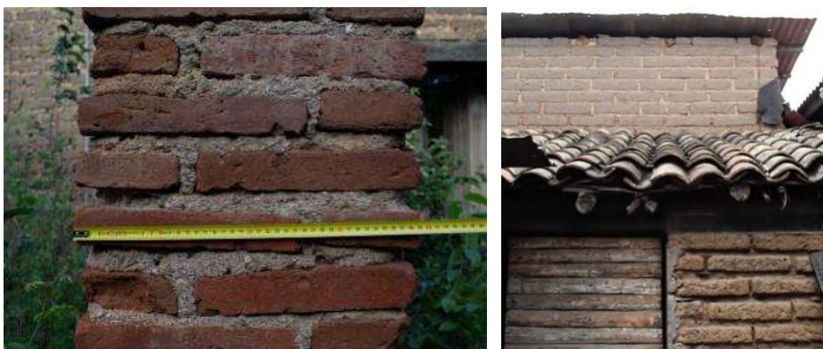
Figura 3.48. Heterogeneidad estructural en las mismas viviendas: (a) Columna de tabique recocido con mortero de unión a base de tierra; (b) Combinación entre sistemas de muros: adobe, madera y bloque de cemento. Fotografías: (I. Velasco-Hernández, K. L. Salvador-Alcalá, 2020).
