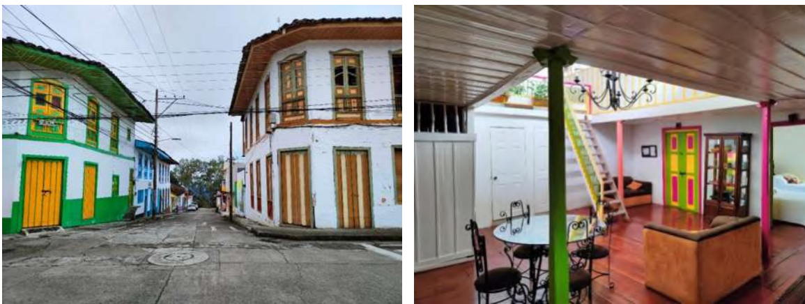
Figura 0.6. Arquitectura de bahareque en el Cairo, Valle del Cauca, Colombia. Fotografías: (A. Sánchez-Calvillo, 2021).
