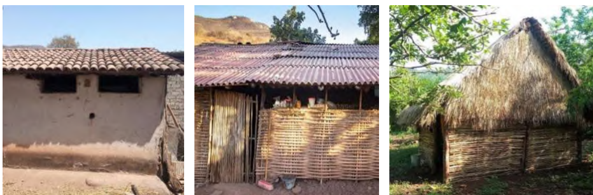
Figura 2.69. Distintas tipologías de cubiertas en viviendas tradicionales de Santa Cruz de Morelos, Michoacán, México. Fotografías: (A. Solís-Sánchez, 2021).
