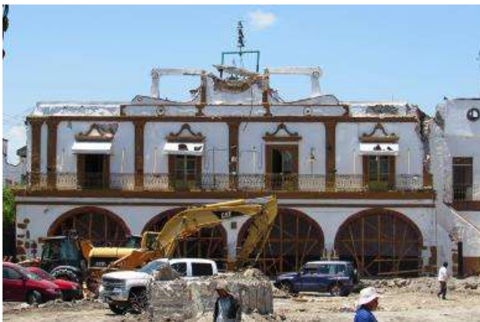
Figura 2.44. Obras de emergencia en el ayuntamiento de Jojutla. Fotografía: (A. Sánchez-Calvillo y E. G. Navarro-Mendoza, 2018).
