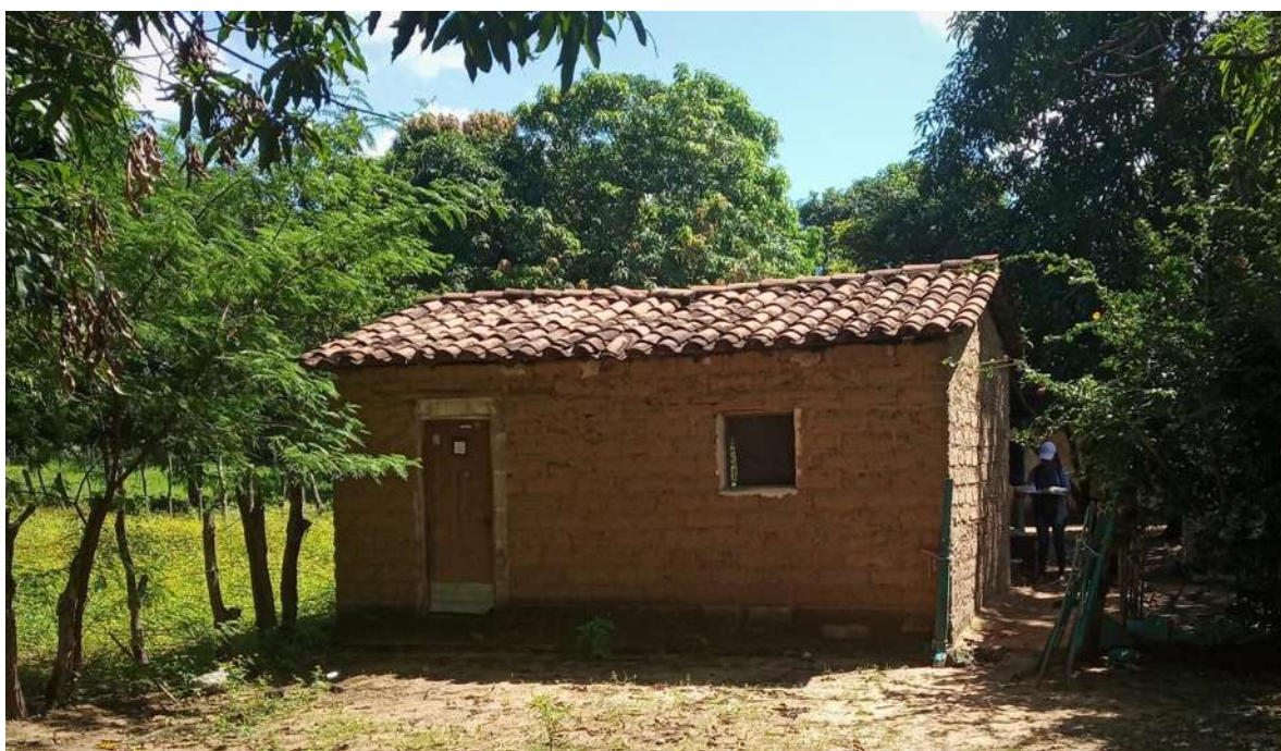
Figura 2.6. Vivienda tradicional de adobe en Jiquipilas, Chiapas, México. Fotografía: (A. Sánchez-Calvillo, 2019).
