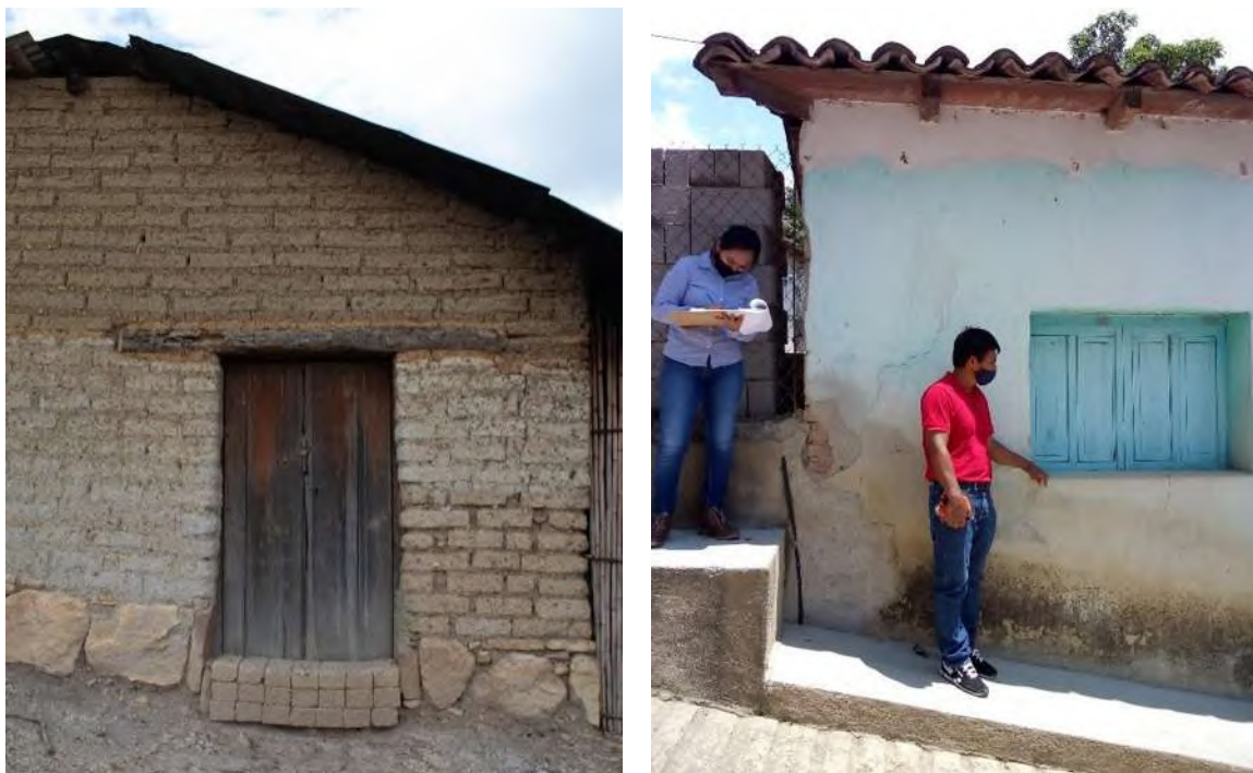
Figura 3.19. Diferencia de cota e inclinación del terreno en viviendas de adobe: (a) Vivienda con cimentación tradicional de roca e inclinación ligera del terreno en SPE, Oaxaca; (b) vivienda en vialidad con pendiente pronunciada en CO, Chiapas. Fotografías: (K. L. Salvador-Alcalá y Y. Velasco-Hernández, 2020; L. J. Díaz-Juárez, 2020).
