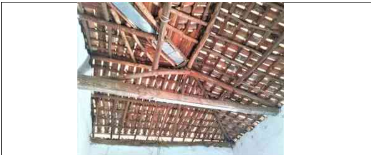
Figura 42.- Ejemplo de cubierta en esquina. Caso de estudio VU-3.
