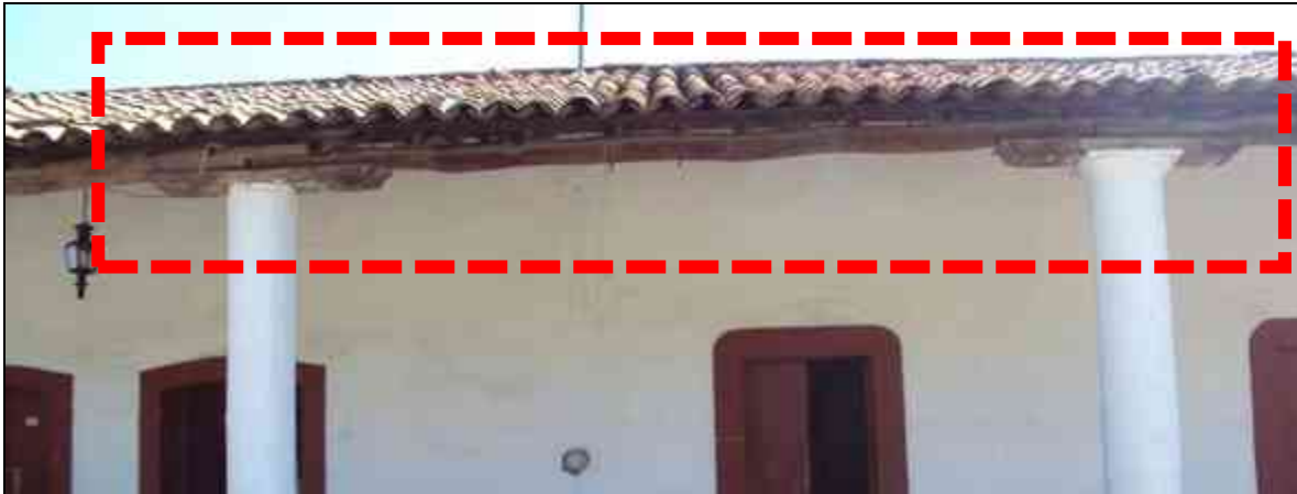
Figura 47.- Fotografía de zapatas sobre apoyos aislados en portal exterior. Caso de estudio VU-2.
