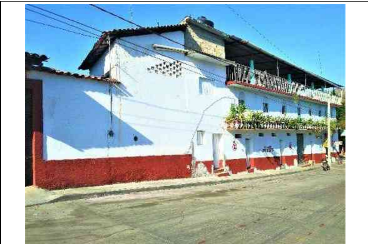
Figura 54.- Fotografía de edificio colindante a la VU-4, en su fachada noreste.
