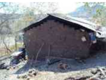
Piedra de río utilizada en la cimentación de las viviendas. Cuando no se tiene la disposición del río, la piedra encontrada en los solares cumple esta función.
