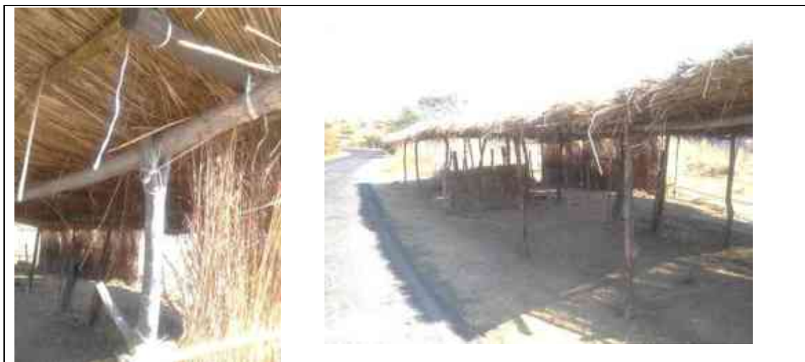
Enramada utilizada como puesto de carretera durante la Fiesta de Ceniza.
