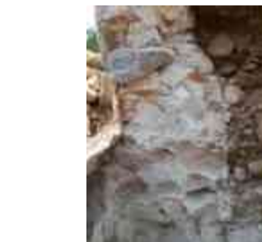
Piedra de río utilizada en la cimentación de las viviendas. Cuando no se tiene la disposición del río, la piedra encontrada en los solares cumple esta función.
